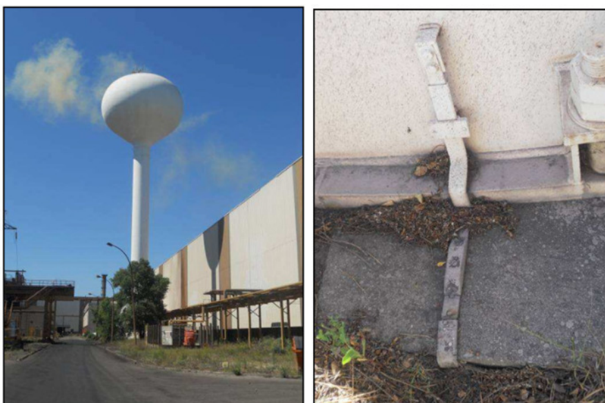
Pointe sèche sur château d'eau chaudière et mise à la terre
