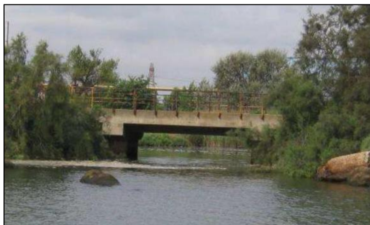
Figure 2. Évacuation du rejet aqueux au nord-ouest de la Darse 1
