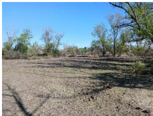
Zone de remblais
