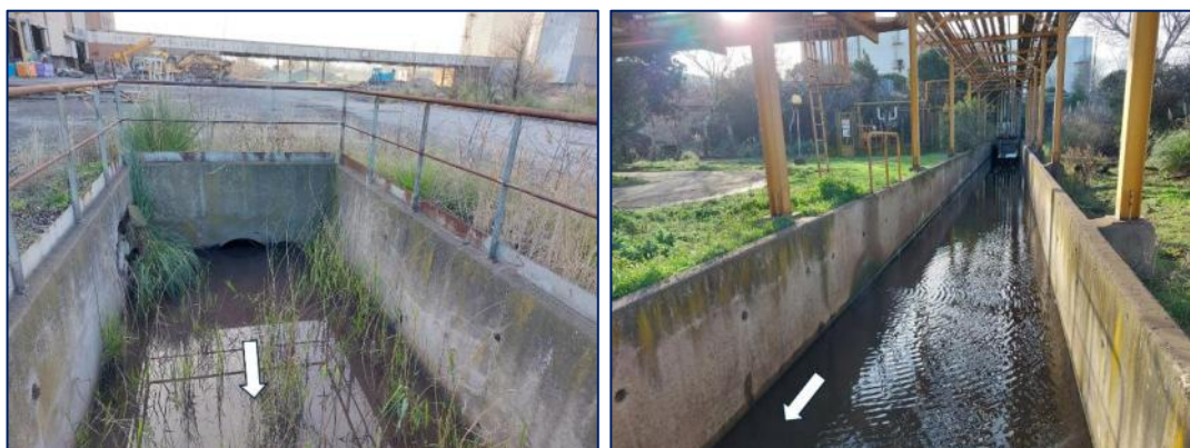
Figure 10 : Roubine en amont du bassin de l'aciérie (photo de gauche) et en aval de l'aciérie (photo de droite)
