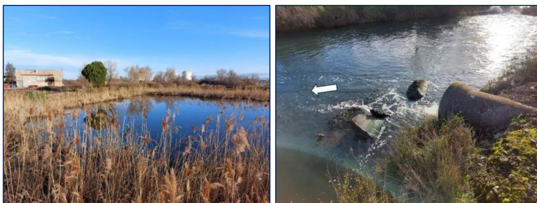
Figure 12 : Bassin à l'exutoire (photo de gauche) et sortie en station de pompage (photo de droite)
