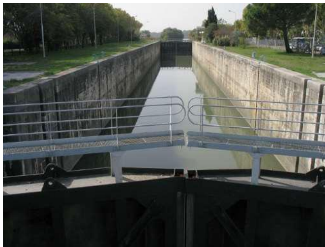
Figure III-28 : Écluse de Barriol
