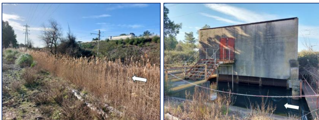
Figure 8 : Roubine de la voie ferrée (photo de gauche) et station de pompage (photo de droite)
