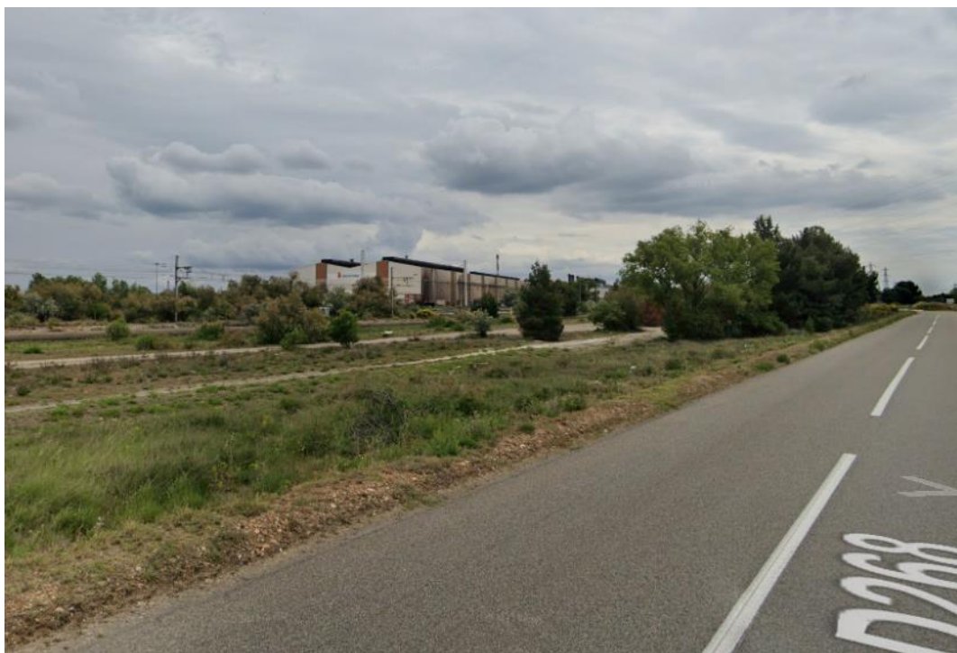
Figure 172 : Vue du site depuis la D268 (photo n°1)
