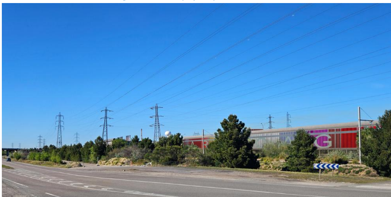
Figure 265: Vue depuis la route du quai Minéralier
