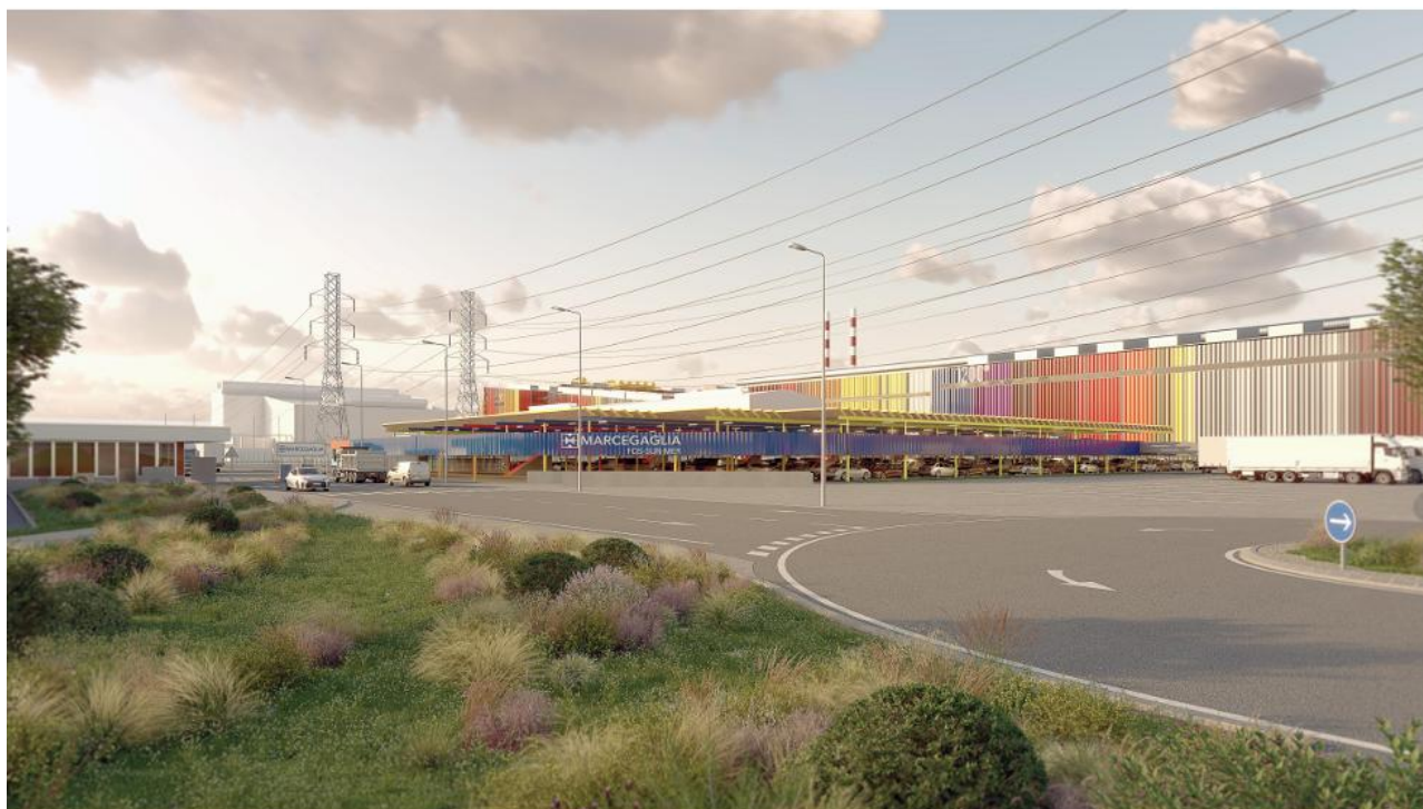
Figure 264: Vue du projet depuis l'entrée du site
