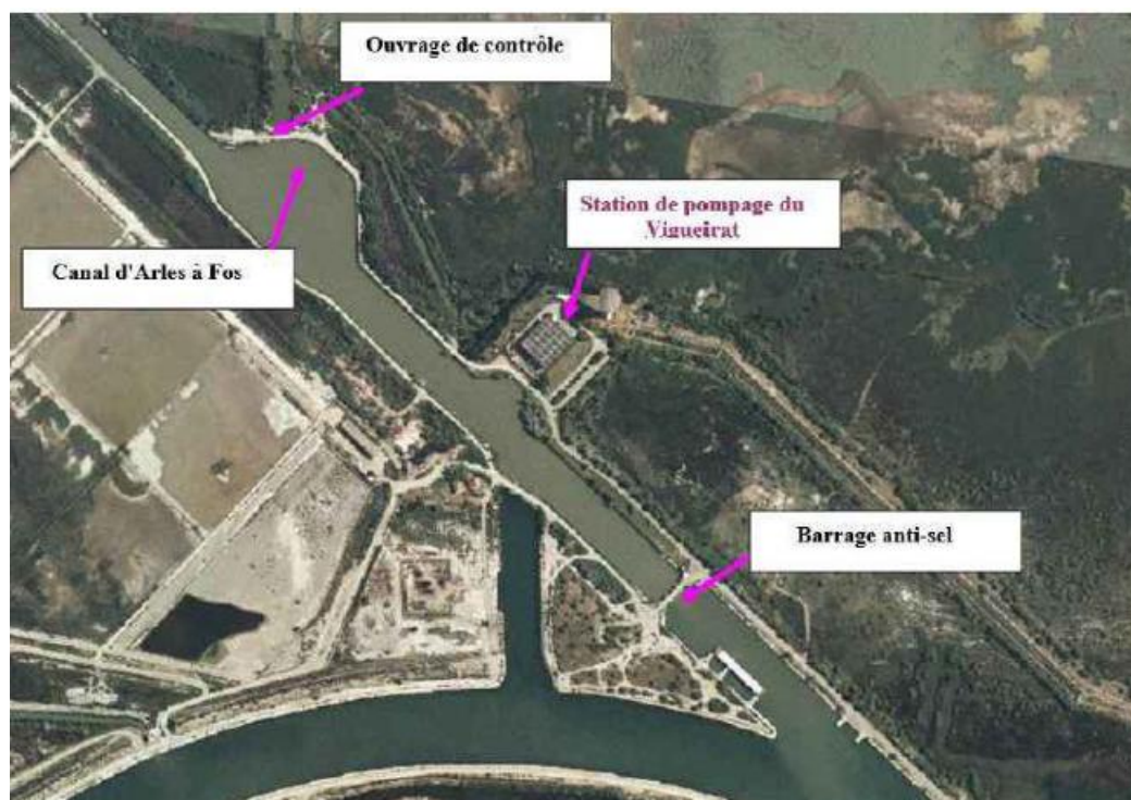
Figure 80: Station et ouvrages de Vigueirat
