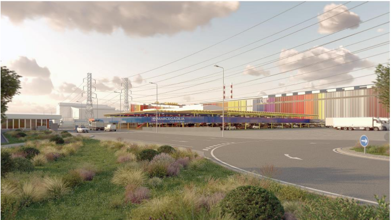
Figure 14: Vue du projet depuis l'entrée du site
