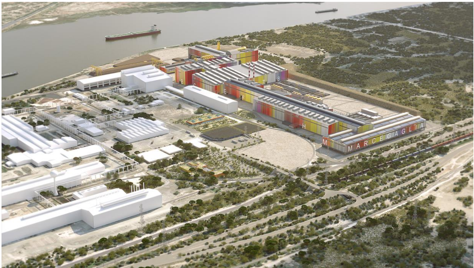
Figure 11: Vue aérienne du projet
