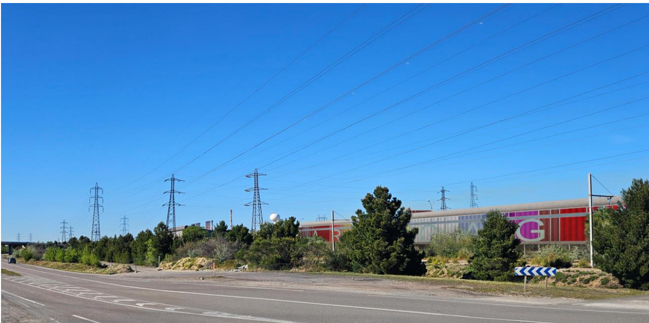
Figure 15: Vue depuis la rue du quai Minéralier
