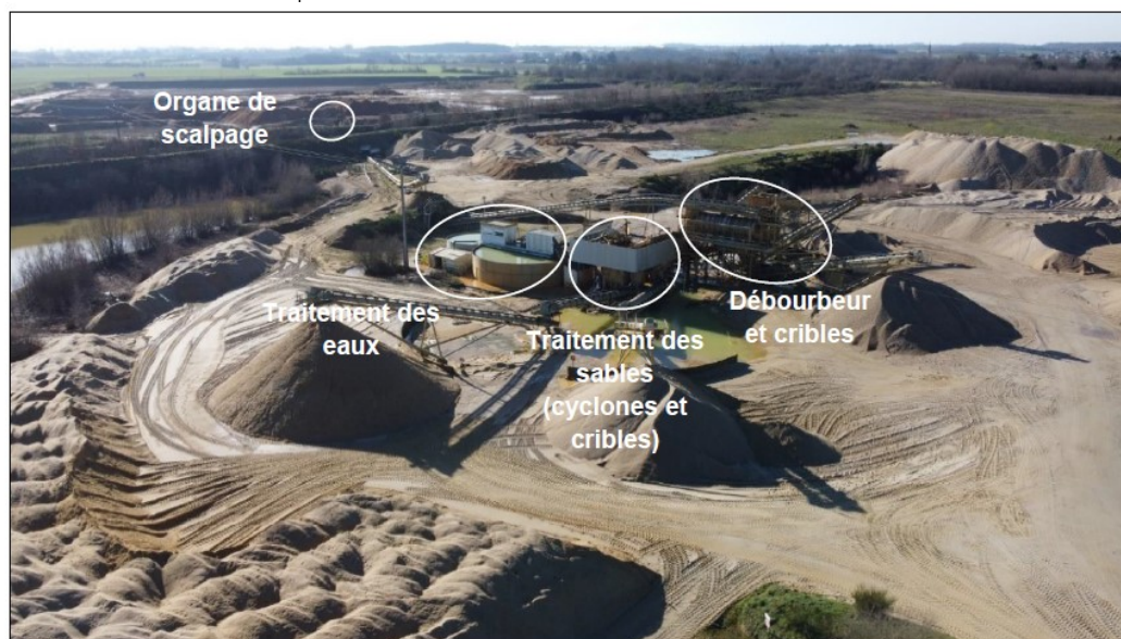
Figure 7 : Installation de traitement actuelle, vue depuis le nord-est (20/01/2023)
