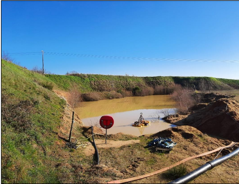
Figure 5 : Bouée équipée d'une touline en bordure du bassin d'eau claire des installations (20/01/2023)
