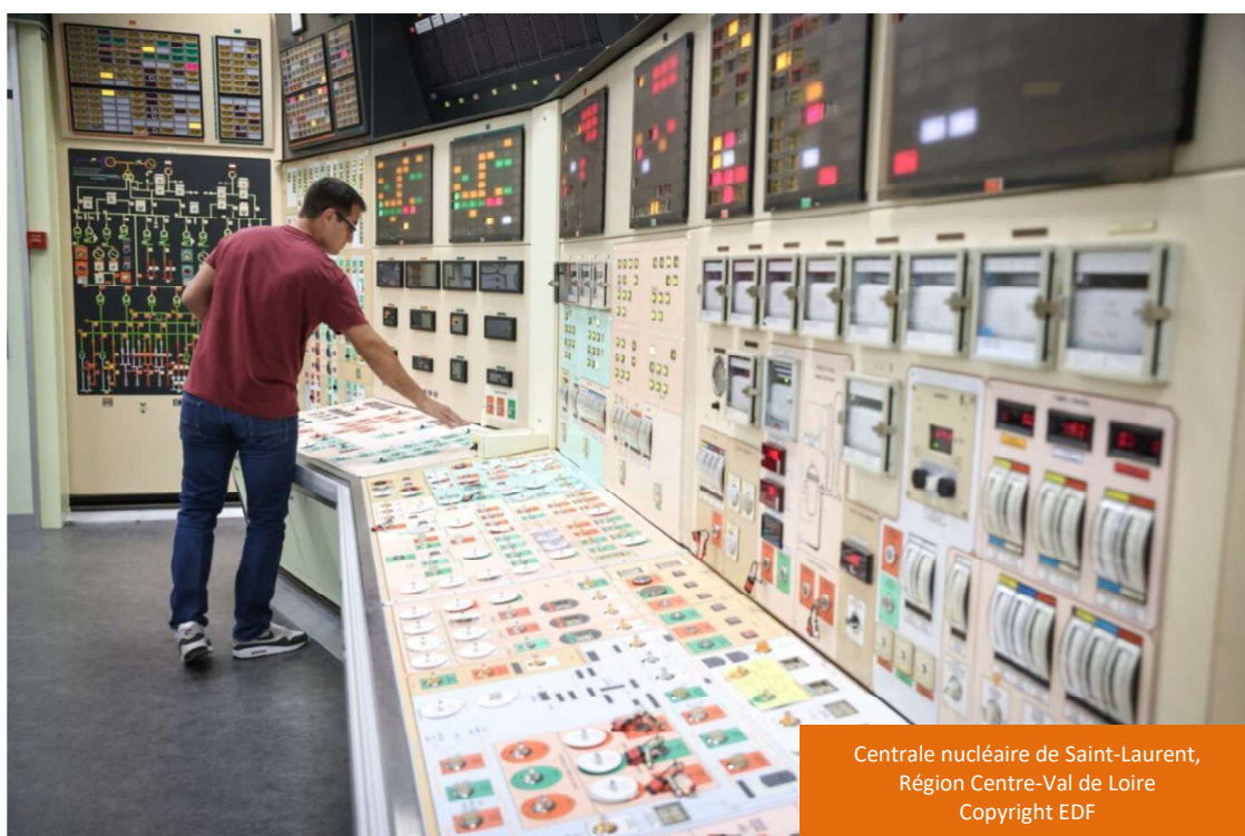
Figure 18. Salle de commande d'un réacteur 900 MWe
