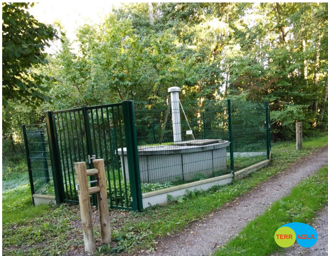
Photographie 1 : captage de la Fontaine Saint-Jean et son périmètre de protection immédiate (prise de vue : Terraqua le 04/10/2022)
