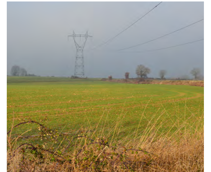
Photographie 62 : Ligne THT traversant la ZIP.
