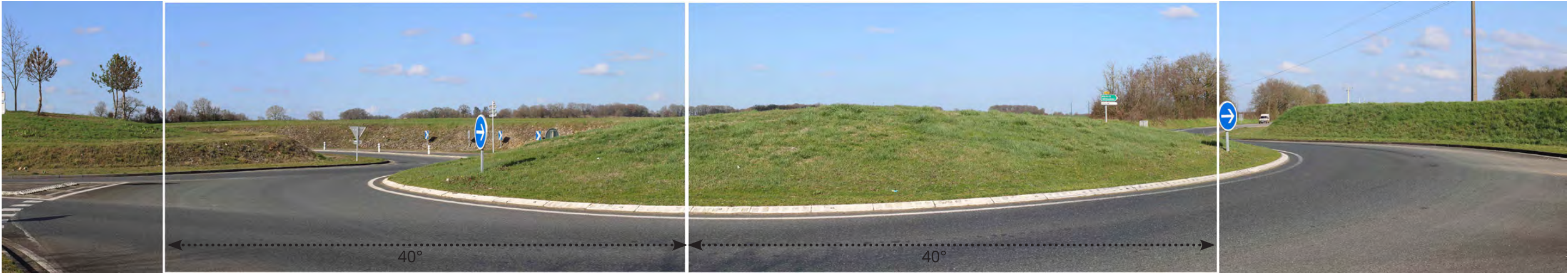
Photographie 69 : Vue de l'état initial (variante 3).
