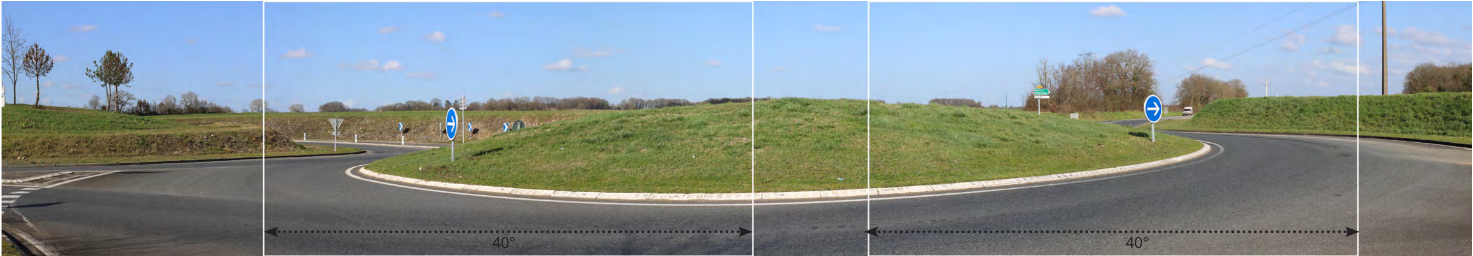
Photographie 68 : Vue de l'état initial (variante 2).
