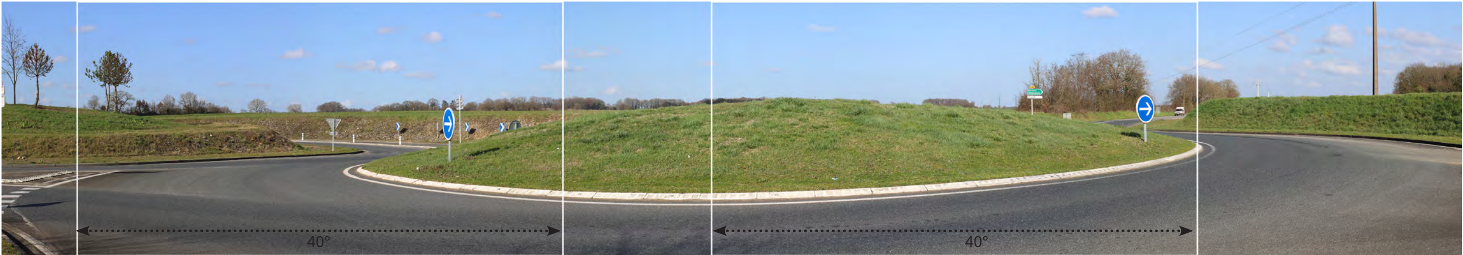
Photographie 67 : Vue de l'état initial (variante 1).
