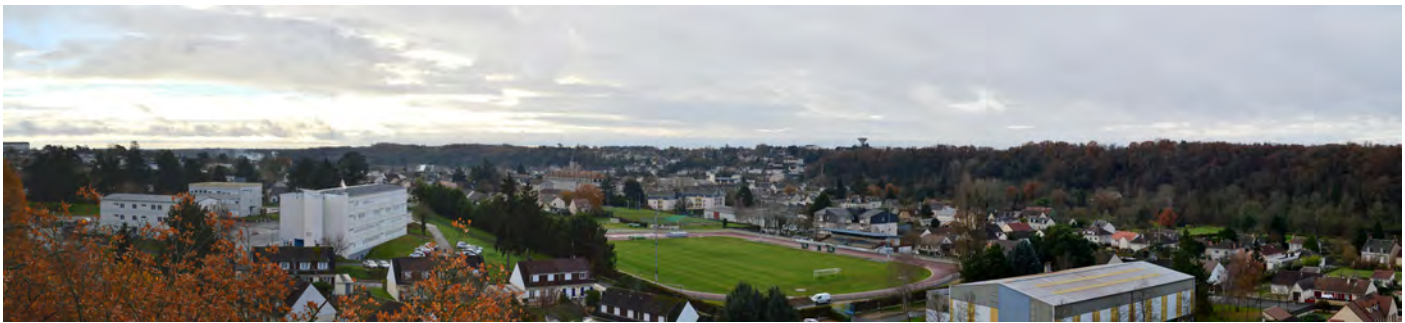
Photographie 46 : Vue d'ensemble du SPR du Blanc depuis le viaduc au nord du bourg.
