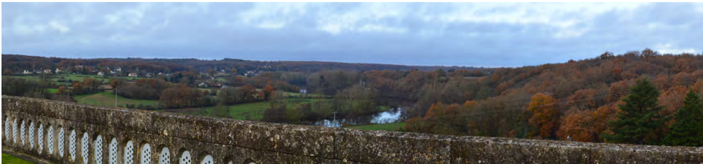
Photographie 1 : La vallée de la Creuse depuis le viaduc du Blanc.
