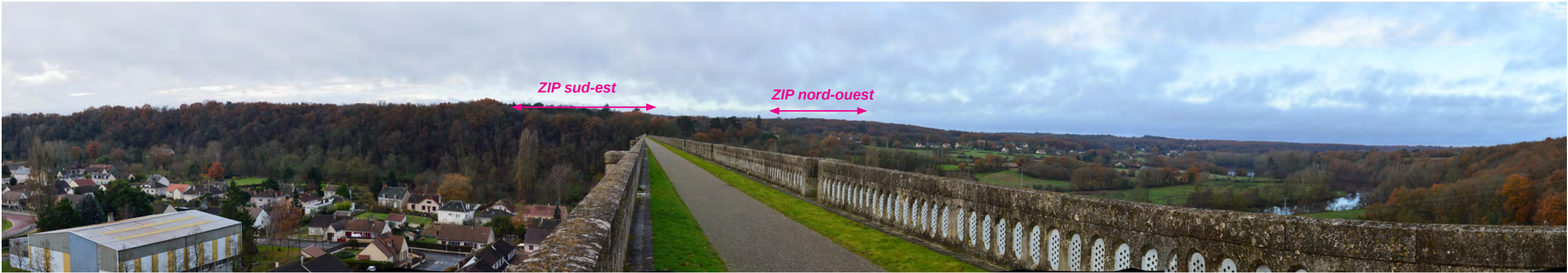
Photographie 50 : Vue dégagée depuis la voie verte empruntant le viaduc de l'ancienne voie ferrée au Blanc.
