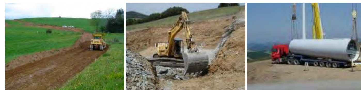
Photographie 104 : Illustration d'un chantier éolien.
