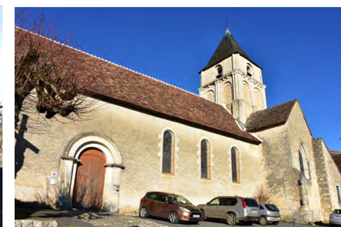
Photographie 19 : Eglise d'Angles-sur-l'Anglin (MH 54).
