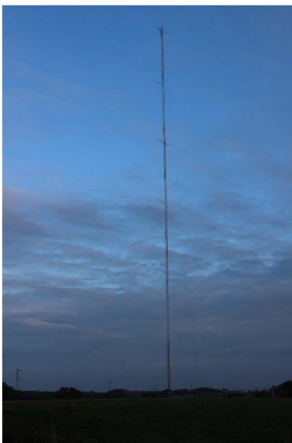
Photo du mât de mesure à la fin de son installation en novembre 2021
