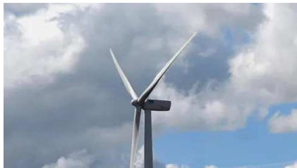
Indre : le mode d'emploi du projet éolien en Pays blancs
