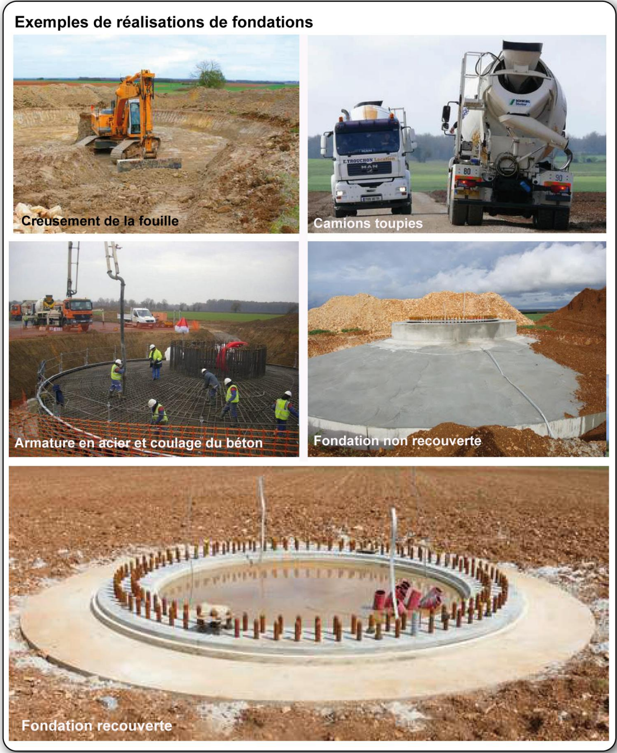
Photographie 35 : Étapes de réalisation d'une fondation d'éolienne
