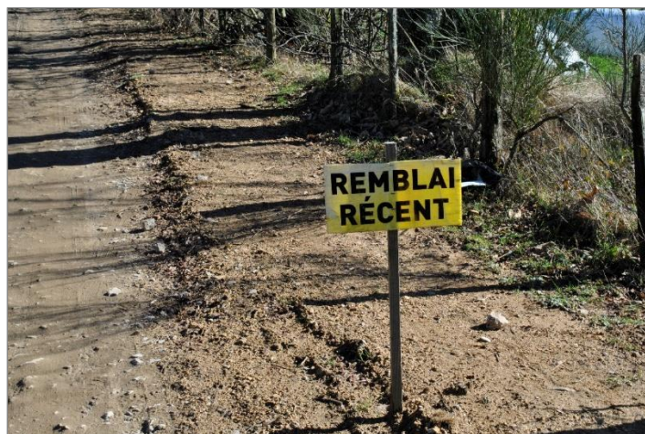
Photographie 38 : Exemple de remblai des tranchées électriques le long d'une piste (Source : ENCIS Environnement)
