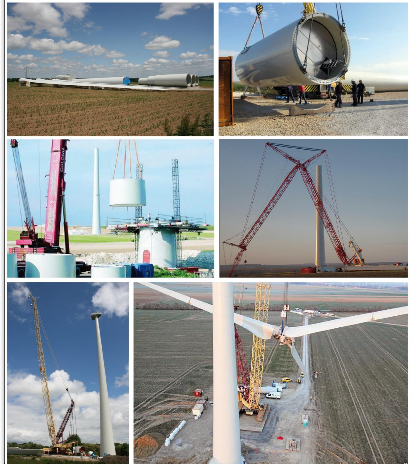
Photographie 37 : Phases d'assemblage d'une éolienne
