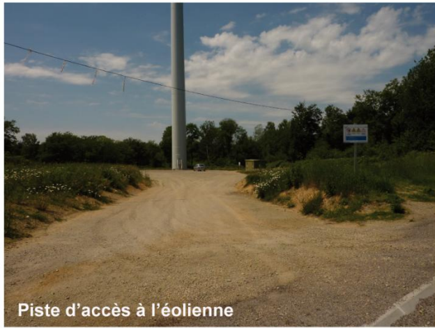
Exemples de pistes et plateformes de montage
