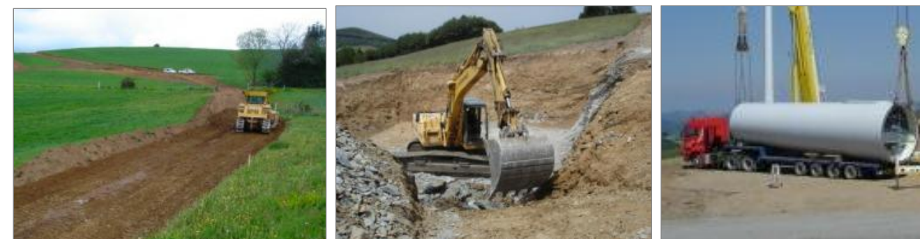
Photographie 40 : Illustration d'un chantier éolien
