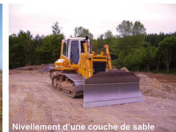
Photographie 34 : Exemples d'engins de travaux de VRD
