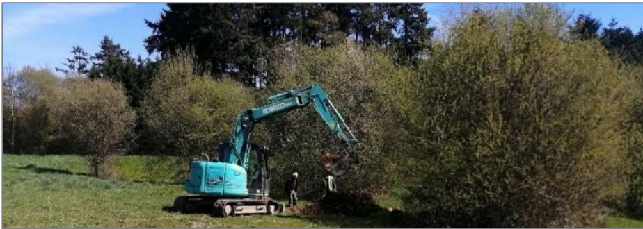
Photographie 49: Sondages géotechniques en vue d'étudier des fondations-pieux non impactantes (Source : ENCIS Environnement)
