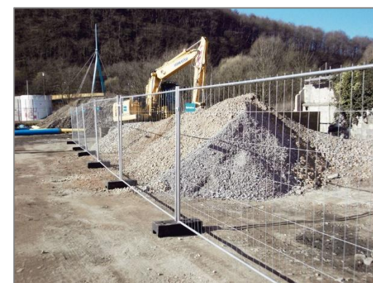
Exemple de clôture mobile Heras utilisée sur les chantiers https://www.denios.fr
