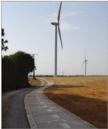
Photographie 51 : Exemple de plaques haute résistance assemblées au sol (Source : L. CAPS Chemins d'Accès et Protection des Sols)
