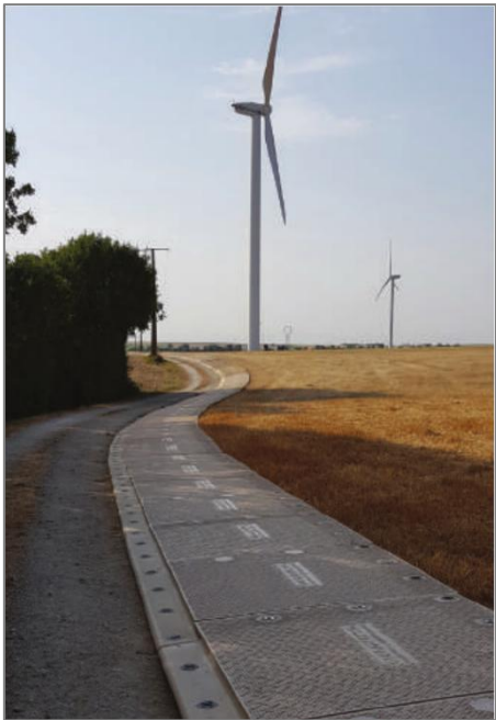
Photographie 31 : Exemple de plaques haute résistance assemblées au sol (Source : L. CAPS Chemins d'Accès et Protection des Sols)
