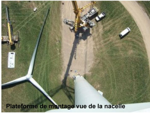
Photographie 32 : Exemples de plateformes de montage et de pistes
