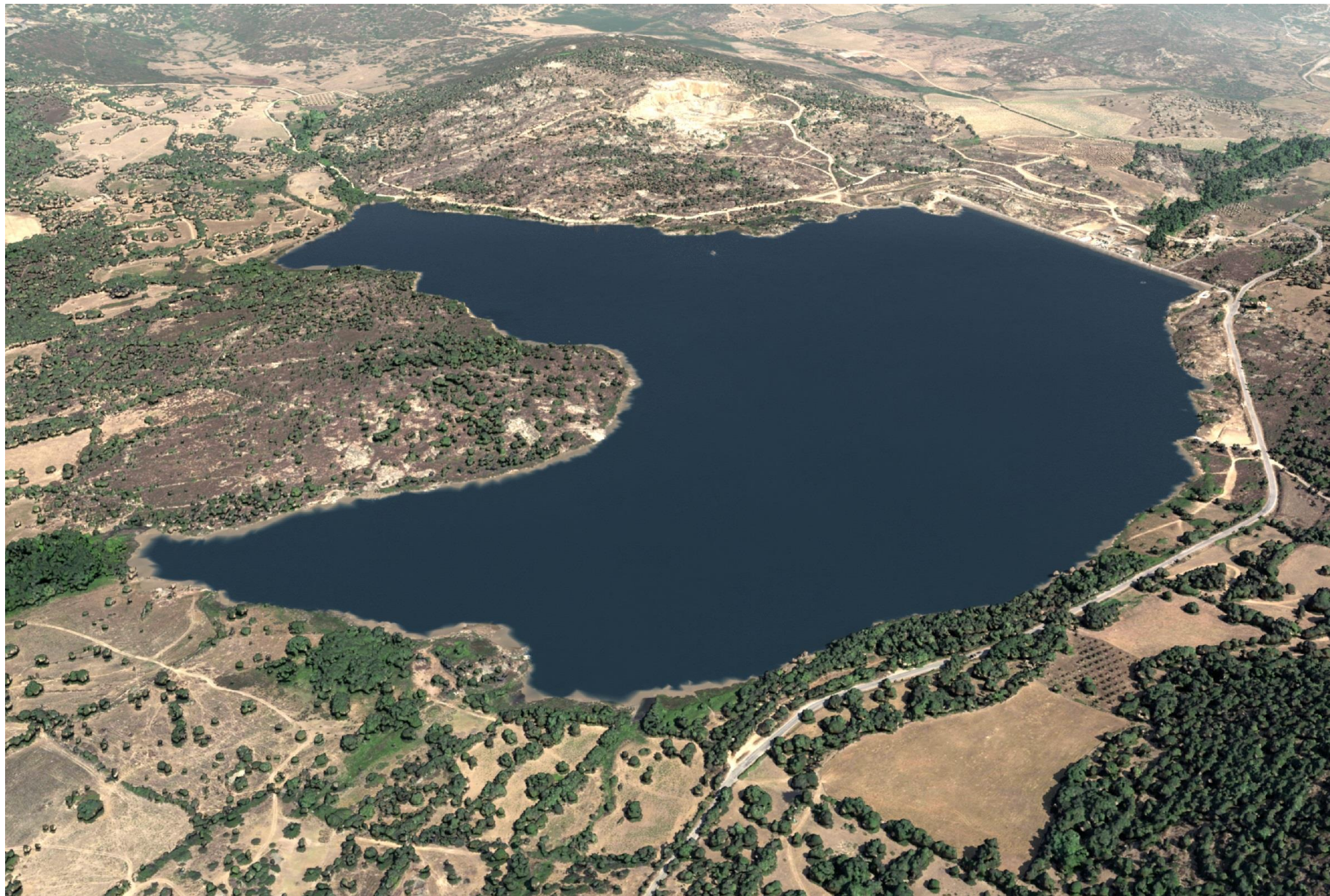
Vue actuelle en rive droite au sud - cote RN – 112.80 m NGF
