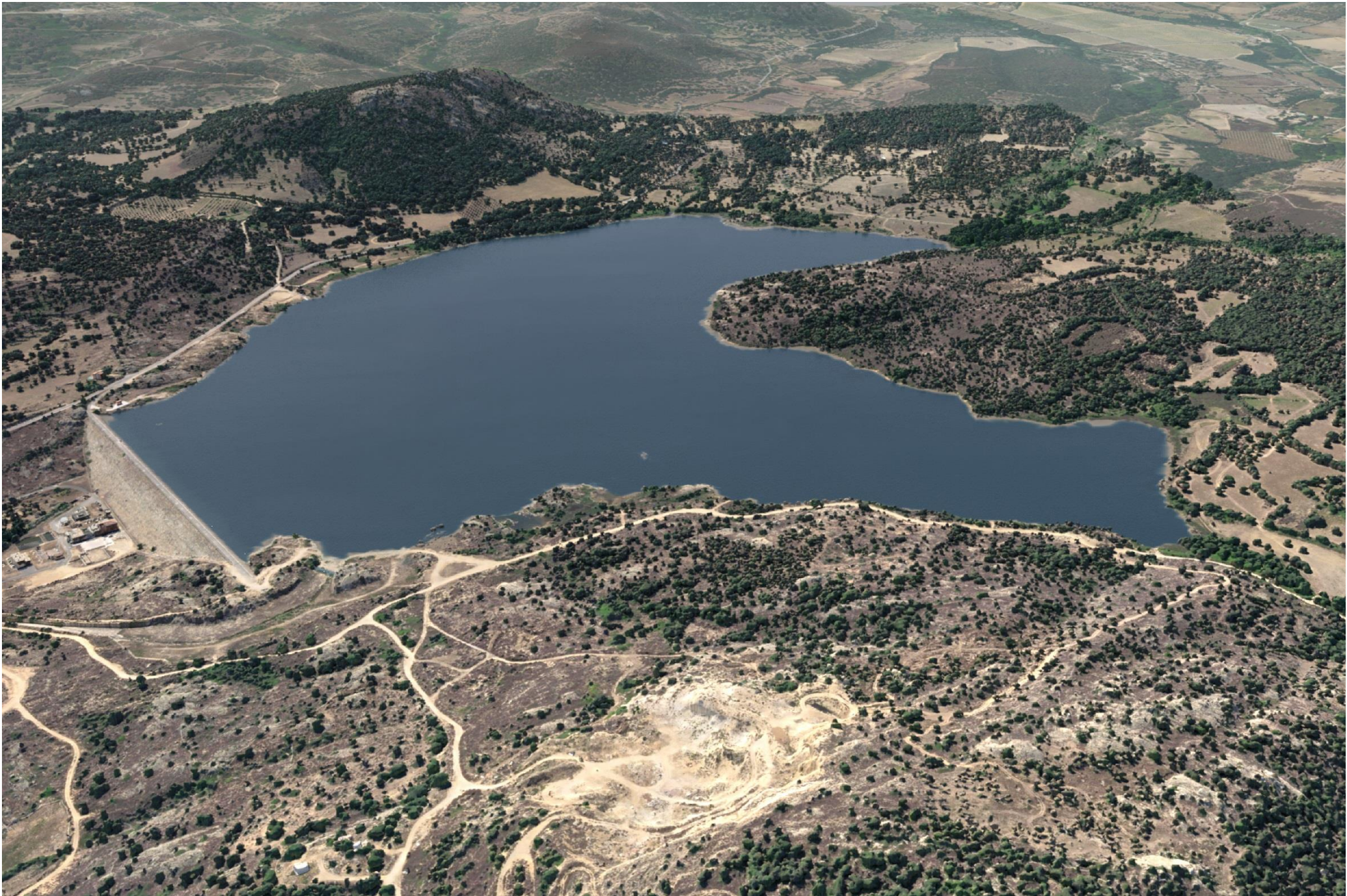
Vue actuelle en rive gauche - cote RN – 112.80 m NGF
