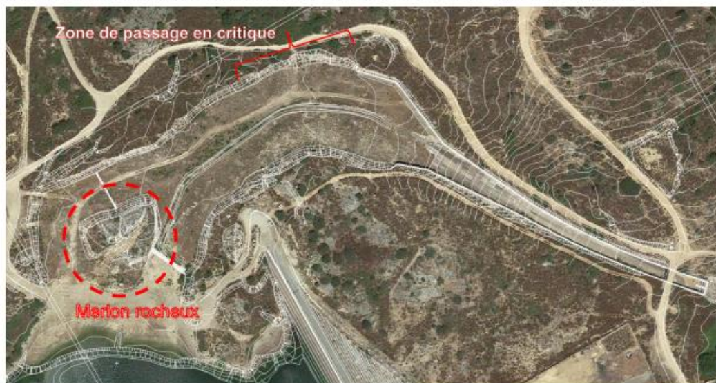
Figure 53 : Zone de déconnexion hydraulique entre le coursier amont et aval
