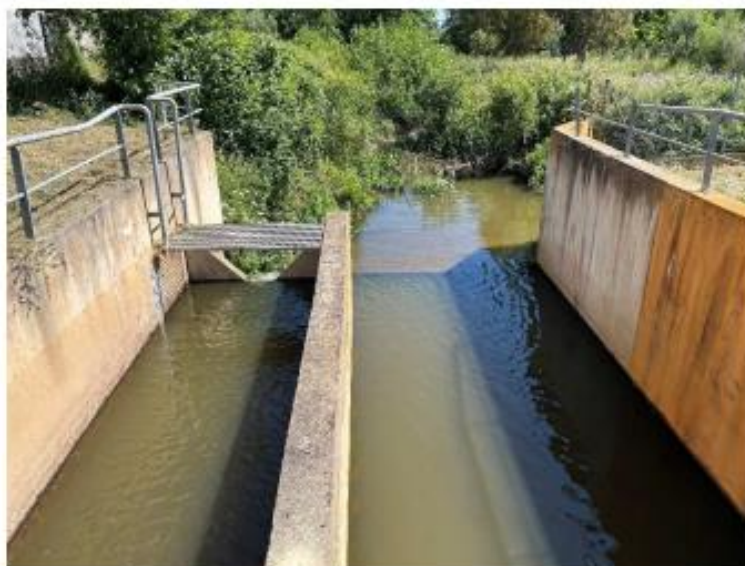
Figure 6 : Ouvrage de restitution
