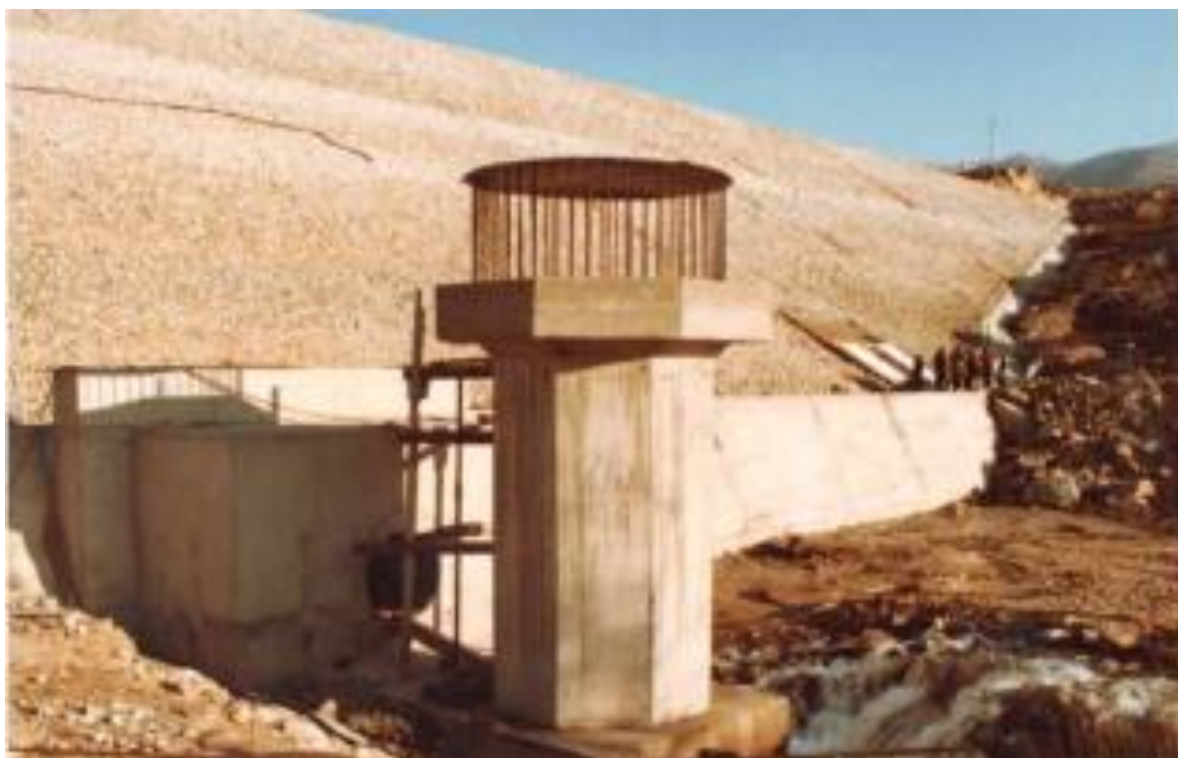
Figure 2 : Vue de la tour de vidange pendant la construction du barrage de Codole – galerie et fourreau en 1500 mm
