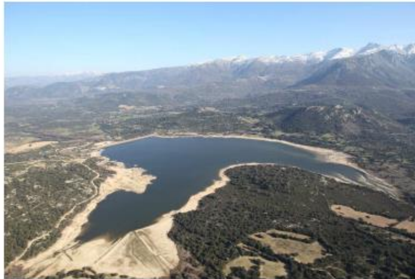
Figure 1 : Photo aérienne du plan d'eau du barrage d'E Cotule
