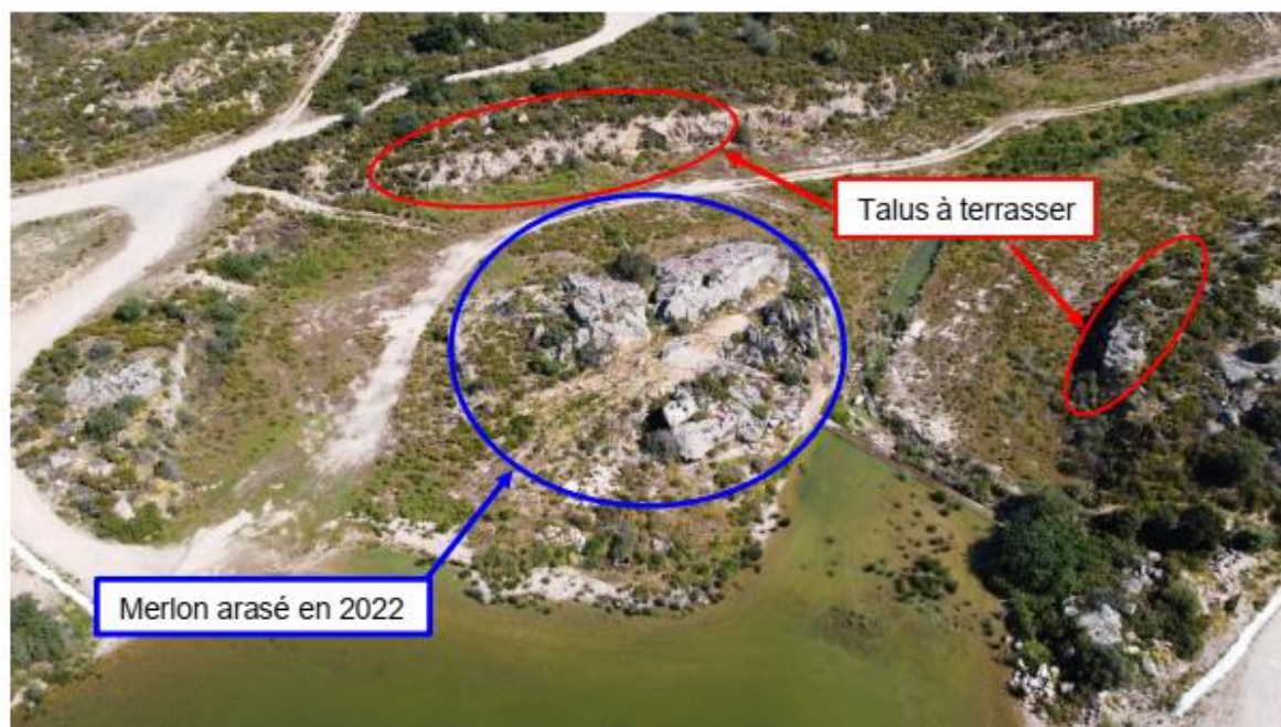
Figure 11 : Talus rocheux à terrasser à l'aval du seuil (source (21F069-RM10_C_PRO_RAPPORT_PRINCIPAL-ISL)– figure 29)
