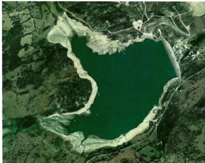
Figure 1 : Vue aérienne du barrage d'E Cotule
