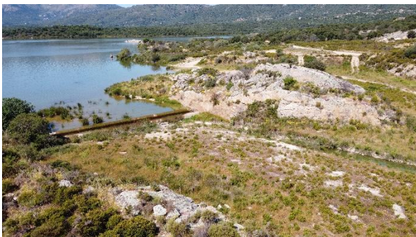
Seuil principal (à droite) (1) (Vue vers l'amont)
