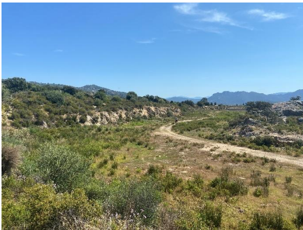
Chenal simplement excavé au rocher (2) (Vue vers l'aval)
