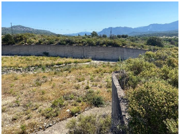
Chenal excavé au rocher et bordé par des bajoyers en béton (3) (Vue vers l'aval)
