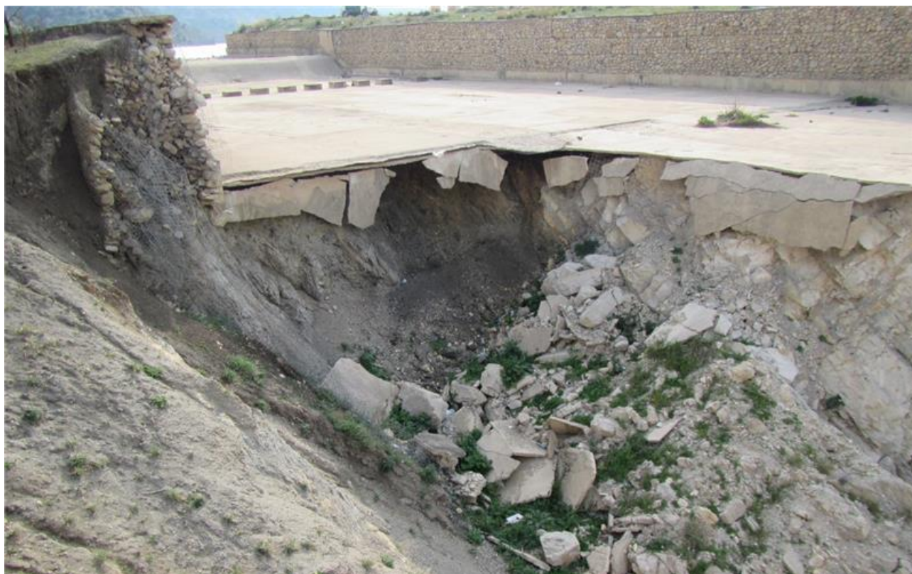
Figure 17 : Endommagement du coursier de l'évacuateur de Medjez B'Gar (source ISL)
