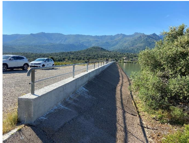
Figure 55 : Muret pare-vague (rive gauche)
