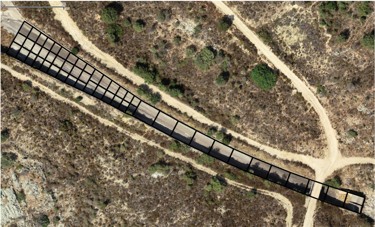
Figure 4 : Dalles du coursier béton
