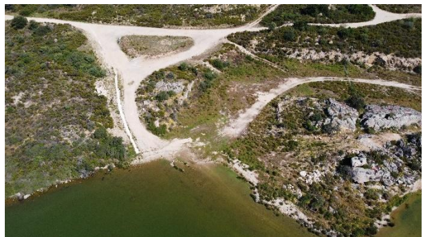
Seuil secondaire (à gauche) (1) (Vue vers l'aval)
