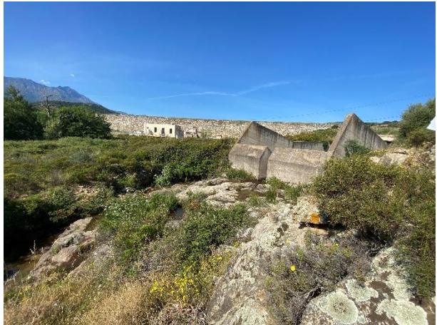
Bassin de dissipation entaillé dans le rocher (6)
