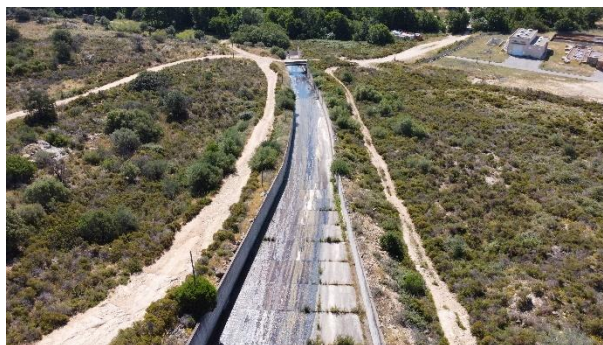
Coursier en béton avec un radier et deux bajoyers (4) (Vue vers l'aval)
