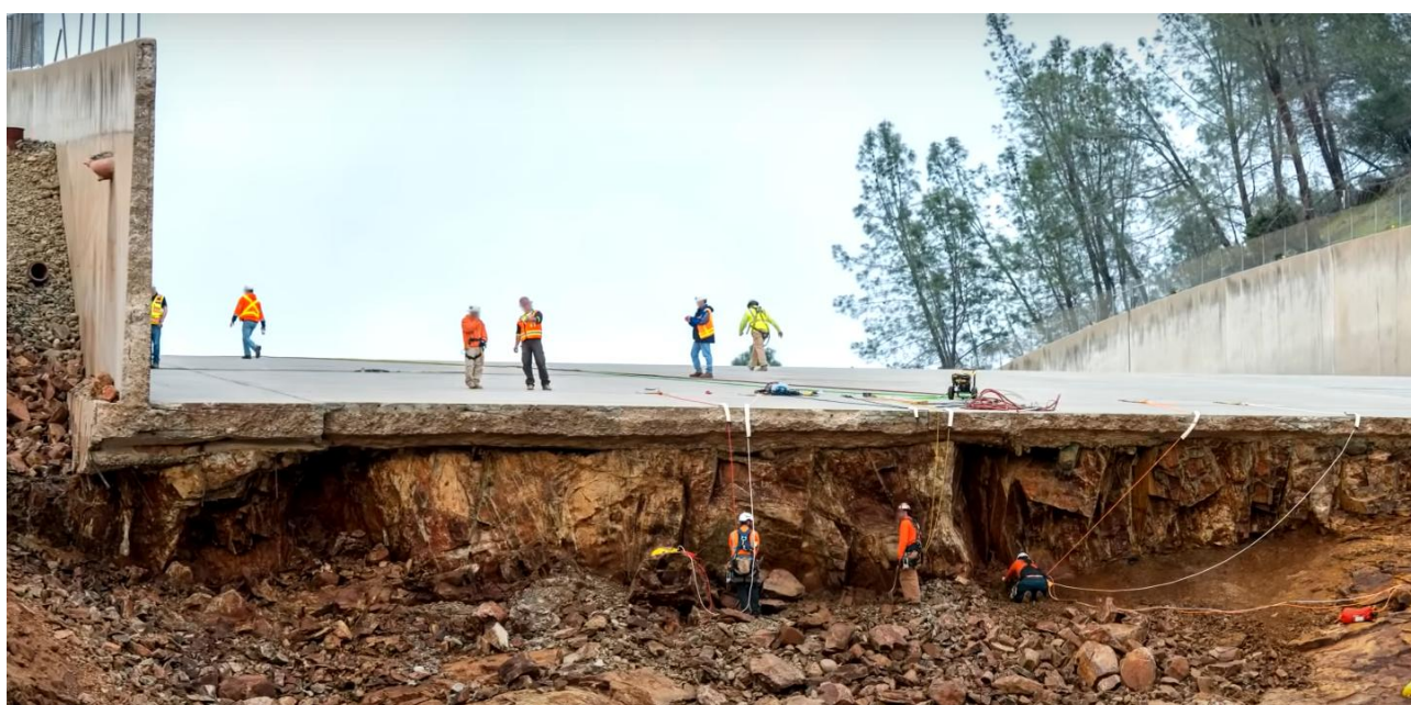
Figure 17 : Endommagement du coursier de l'évacuateur de Medjez B'Gar (source ISL)
