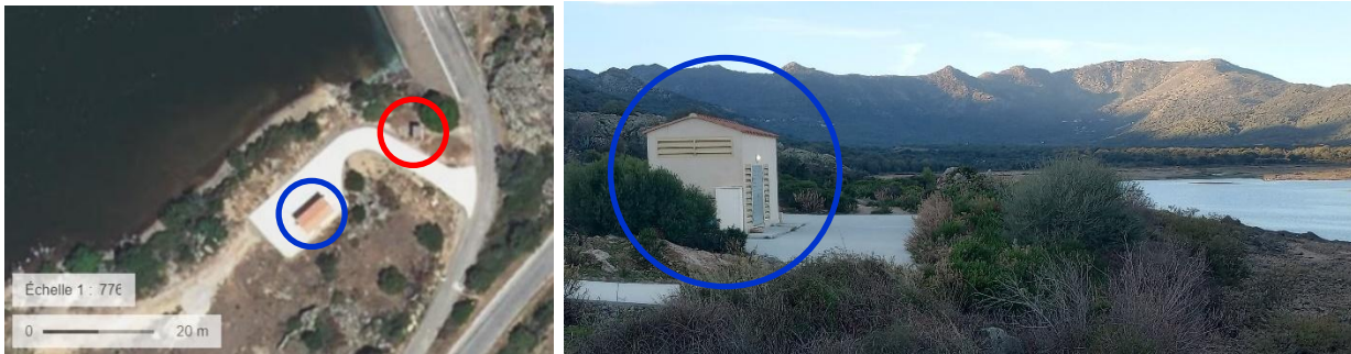
Figure 66 : Locaux techniques (pour aération à droite)
