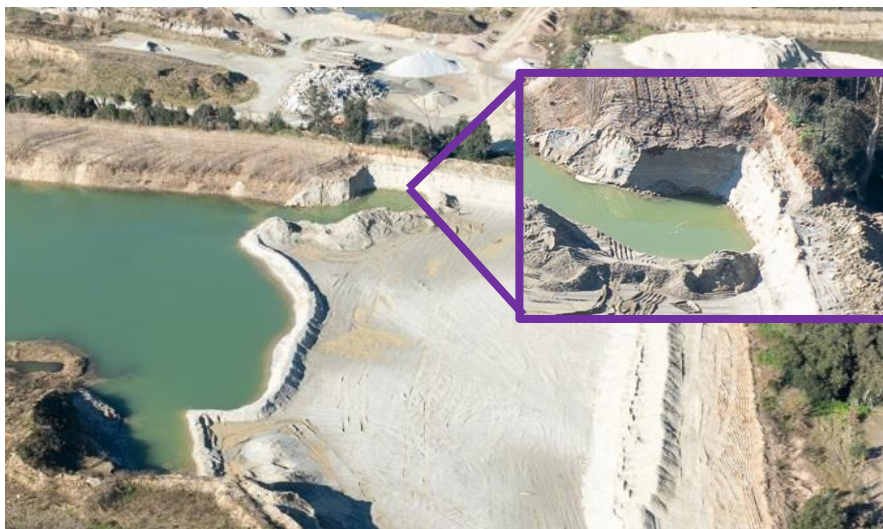
Front d'excavation de référence (encadré violet)
