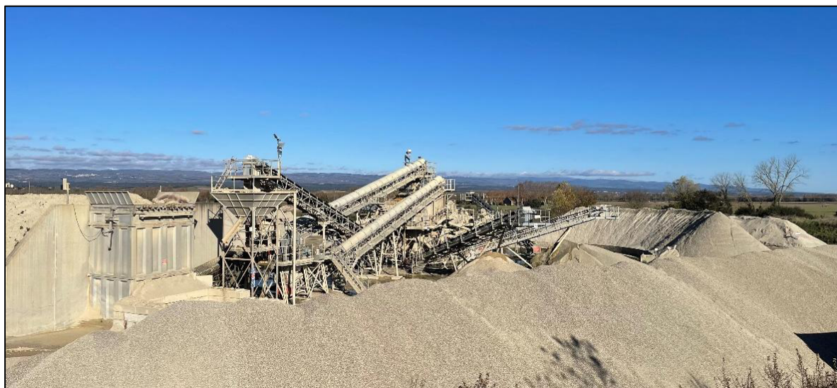
Figure 8. Installation de traitement (Géoenvironnement, Déc. 2024)
