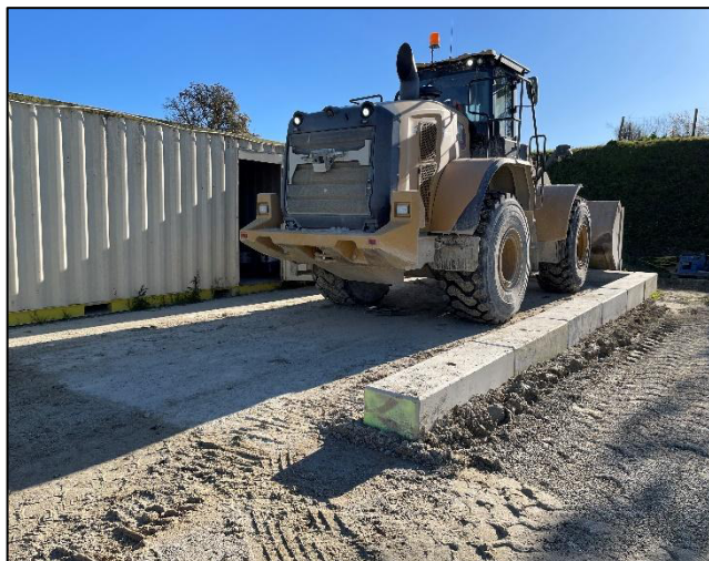
Figure 6. Aire étanche (Géoenvironnement, Déc. 2024)
