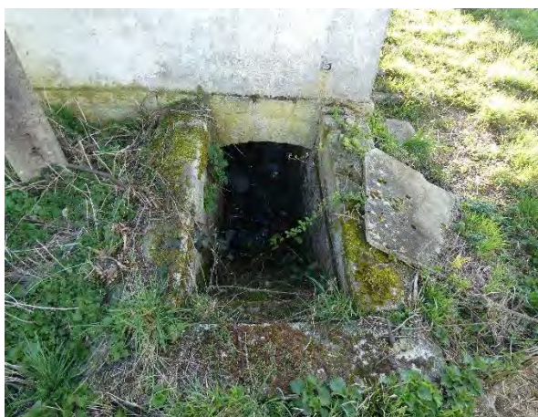
Figure 6. Entrée à la cave du bâtiment (Ecosphère, 2026)
