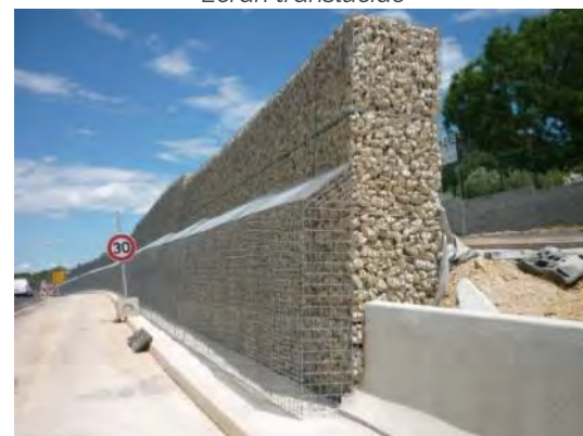
Ecran en gabions
