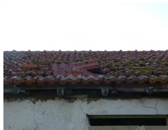
Figure 5. Accès à la toiture (Ecosphère, 2026)
