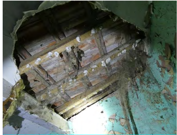
Figure 9. Ouverture par la charpente (Ecosphère, 2026)
