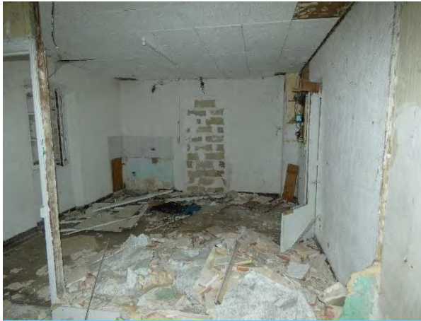
Figure 8. Intérieur du bâtiment (Ecosphère, 2026)
