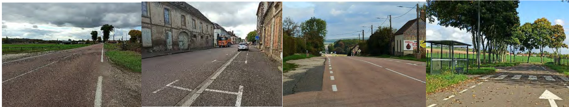
De gauche à droite : RD660 au niveau du projet (bas-côtés sans cheminements), RD660 à Villeneuve l'Archevêque (stationnement sur trottoirs), RD660 à Bagneaux (accotements gravillonnés), Aire de covoiturage de Vulaines
