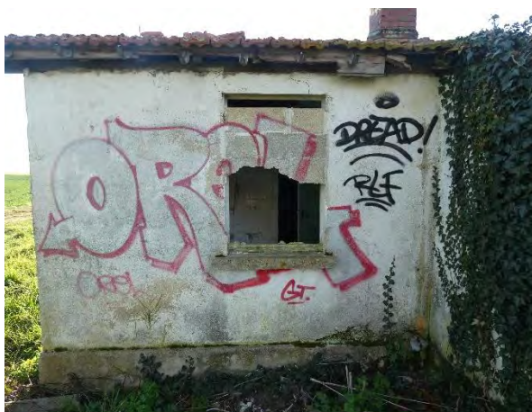
Figure 4. Accès à l'entrée du bâtiment (Ecosphère, 2026)
