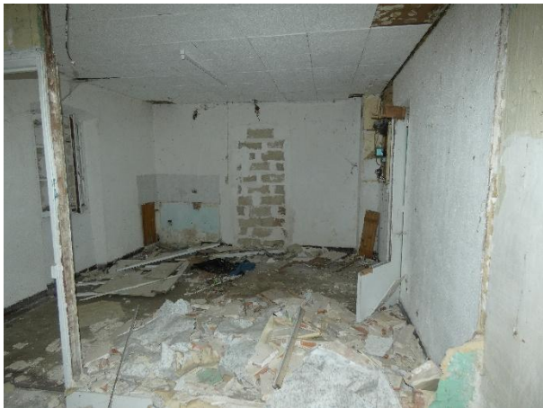
Figure 84 : Intérieur du bâtiment (Ecosphère, 2026)
