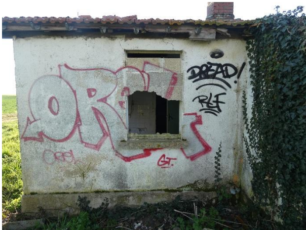
Figure 80 : Accès à l’entrée du bâtiment (Ecosphère, 2026)
