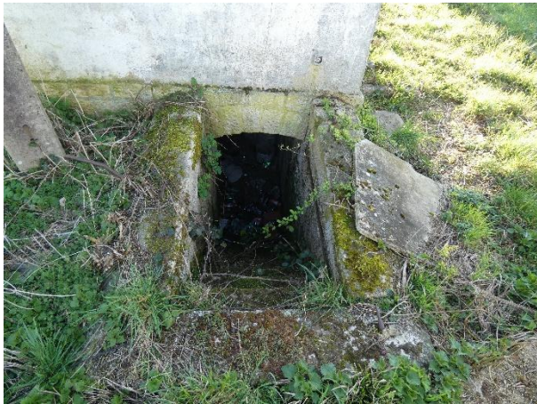
Figure 82 : Entrée à la cave du bâtiment (Ecosphère, 2026)
