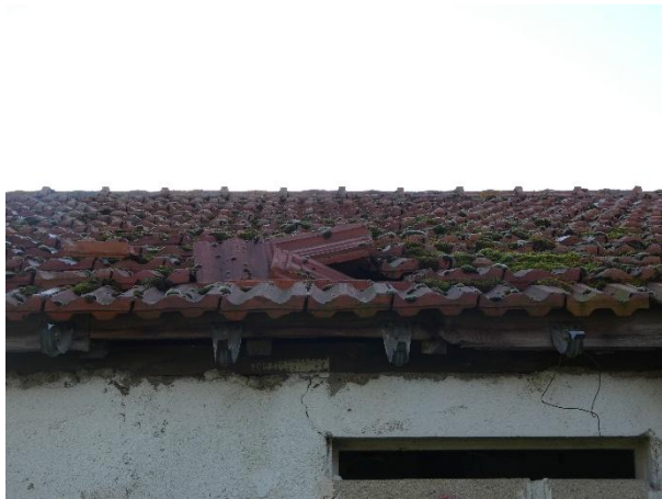
Figure 81 : Accès à la toiture (Ecosphère, 2026)
