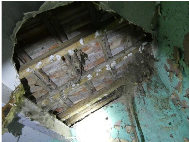
Figure 85 : Ouverture par la charpente (Ecosphère, 2026)
