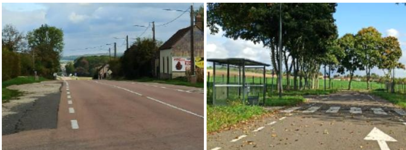
Figure 135 : De gauche à droite, RD660 à Bagnaux (accotements gravillonnés), Aire de covoiturage de Vulaines
