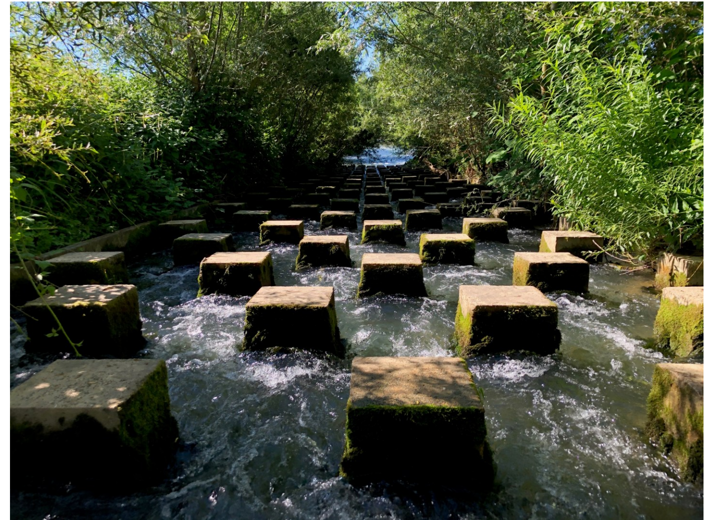
Figure 45 : photo de la passe à poisson existante
