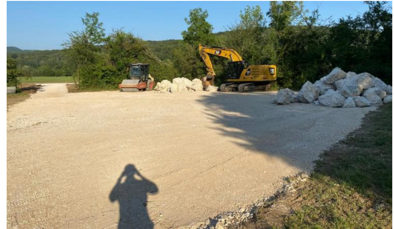
Figure 47 : Photo de la création d'une plateforme de Chantier (geotextile sous concassé) pour la centrale de Port-Lesney
