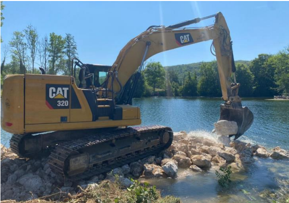
Photos d'une pelle mécanique Saillard TP en huile bio dans le cadre des travaux de Port-Lesney réalisant une gué au fur et à mesure des avancées de la pelle mécanique
