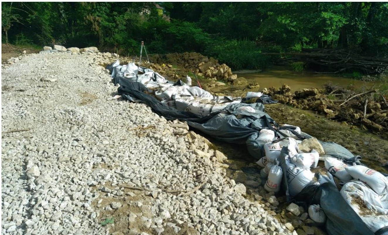
Figure 48 : Photo de la mise hors d'eau du premier tronçon lors des travaux de Port-Lesney
