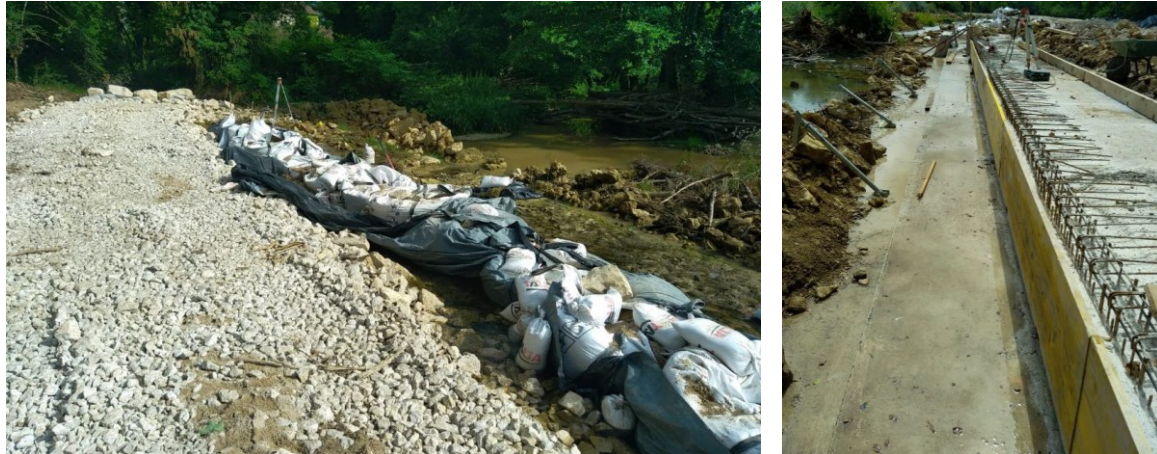
Mise hors d'eau du premier tronçon lors du chantier de Port-Lesney
