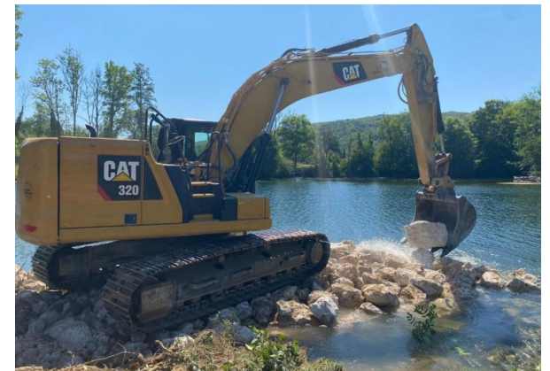
Photos d'une pelle mécanique Saillard TP en huile bio dans le cadre des travaux de Port-Lesney
