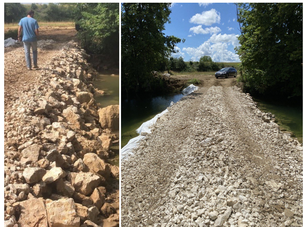
Photos de pistes d'accès réalisées par Nouvergies dans le cadre des travaux de Port-Lesney
