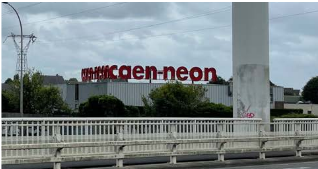
Cumul excessif d'enseignes sur toiture à Mondeville
