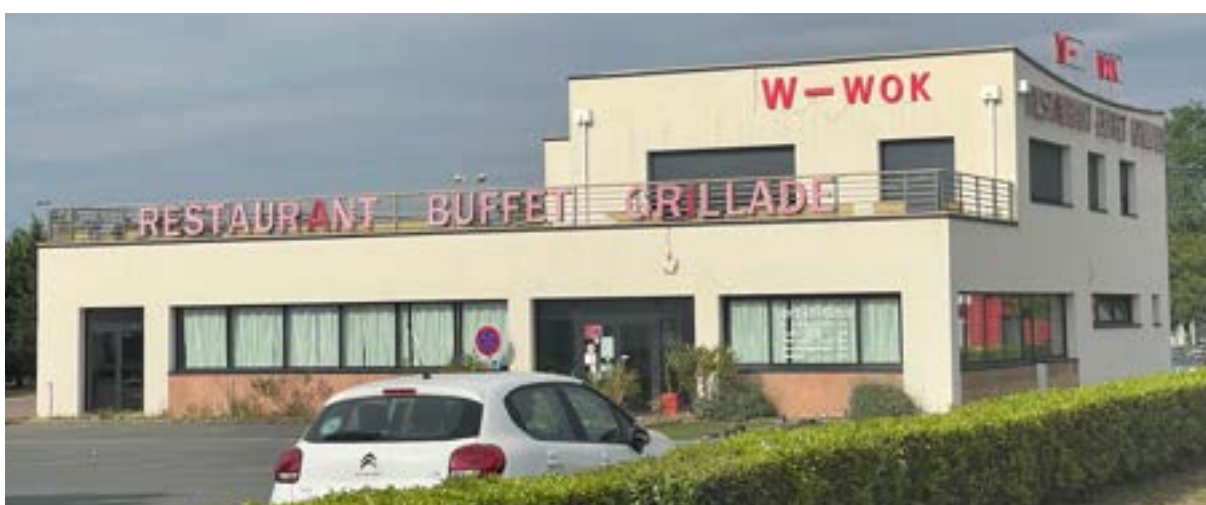
Enseigne sur garde-corps à Ifs
