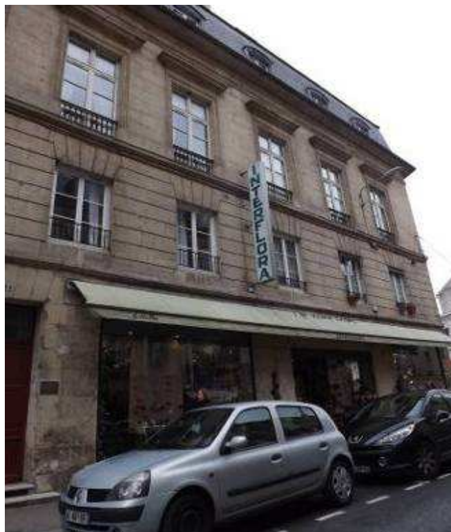
Enseigne drapeau située dans les étages non commerciaux
