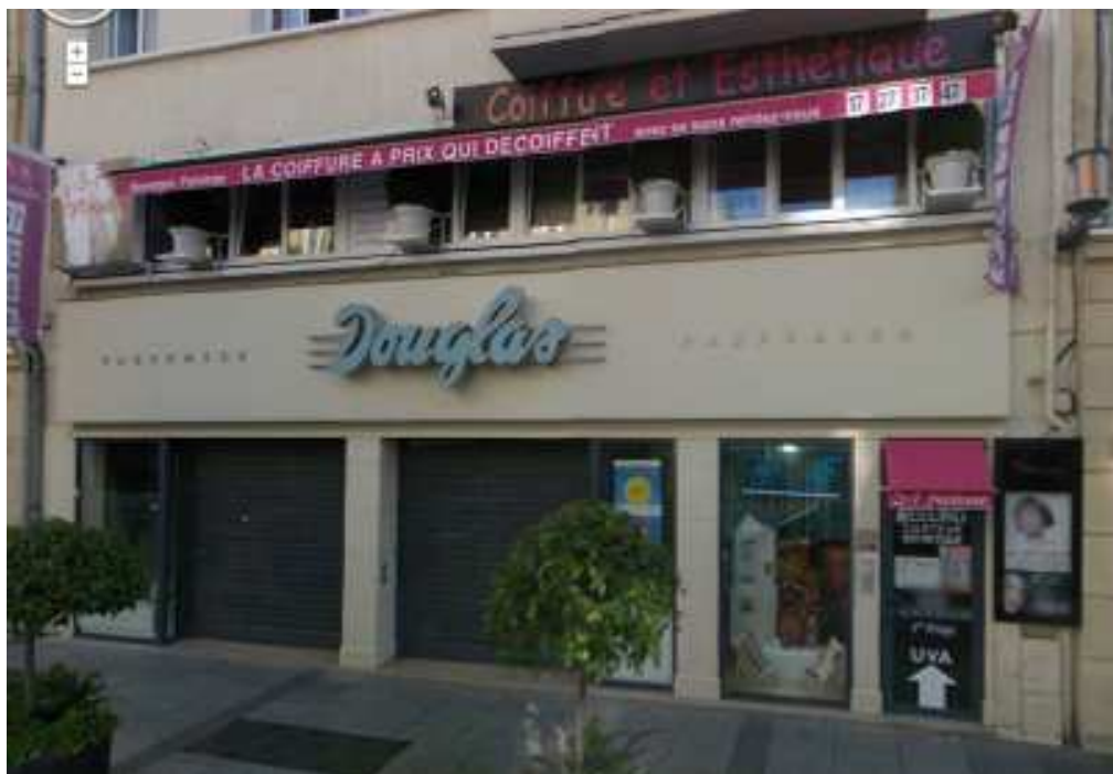
Les enseignes sur les étages ne respectent pas l'architecture du bâtiment
