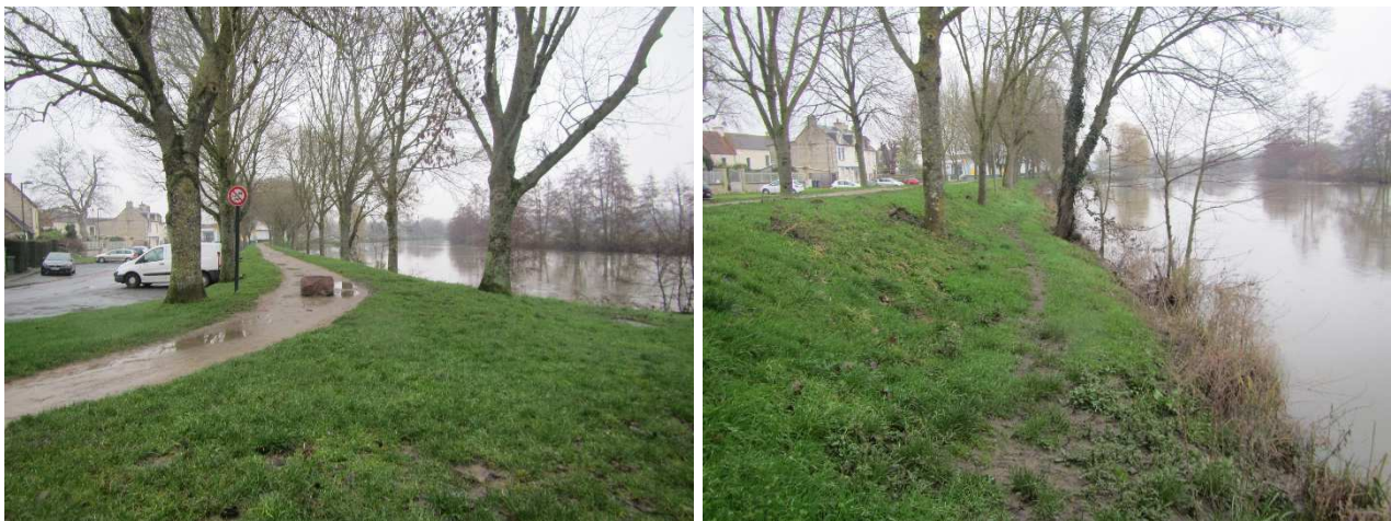
Figure 7-10 : vues générales du tronçon LOU_04.
