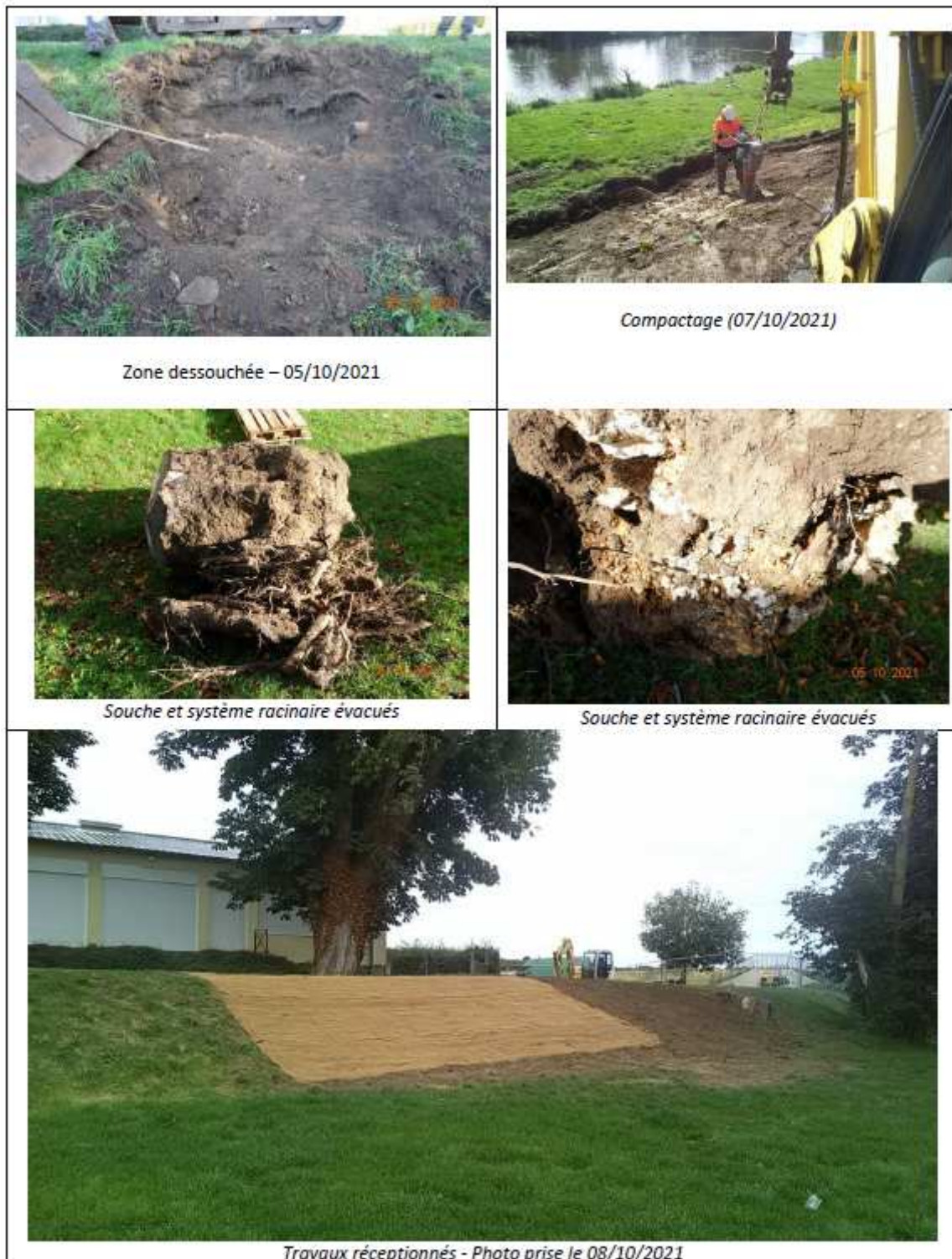
Figure 7-26 : compte-rendu photographique des travaux de réparation – octobre 2021.
