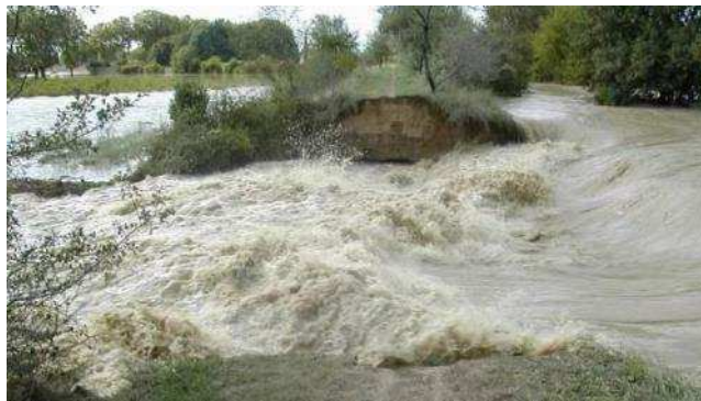
Figure 6-3 : Rupture de digue par surverse du Vidourle à Marsillargues lors de la crue de septembre 2002 (source : mairie de Marsillargues).
