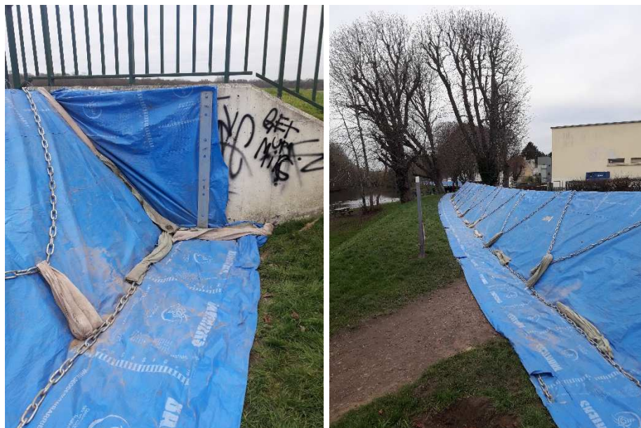
Figure 7-14 : aperçu du montage du dispositif d'Aqua-barrières lors du test de 2019. Détail de la jonction sur le mur en béton (LOU_06).
