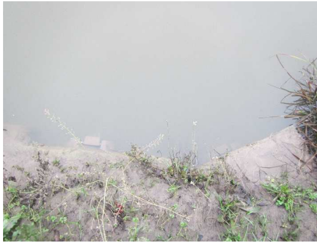
Figure 7-29 : clapets n°6 et 7.
