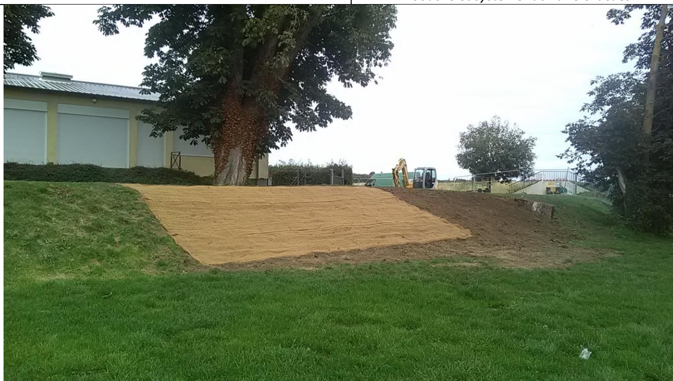
Travaux réceptionnés - Photo prise le 08/10/2021
