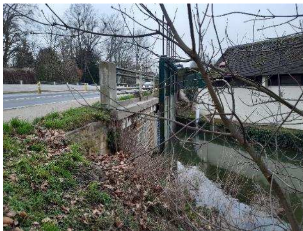
Figure 7-45 : Ouvrages traversants relevés sur le Boulevard Y. Guillou
