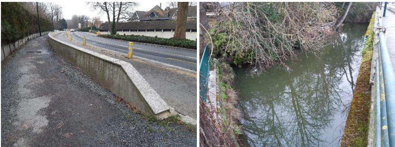
Figure 7-7 : vue d'ensemble de la murette et mur de soutènement au débouché du canal.
