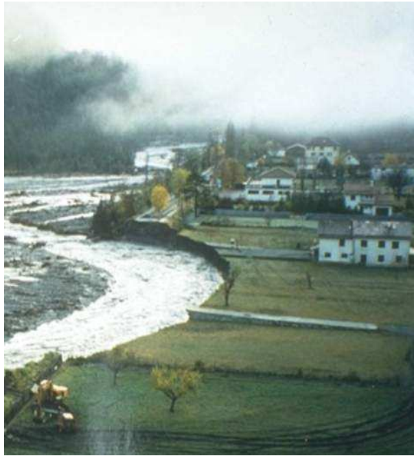
Figure 6-6 : Mobilité fluviale du Var ayant "emporté" un linéaire de la digue de Guillaumes (source : ONF Alpes Maritimes)
