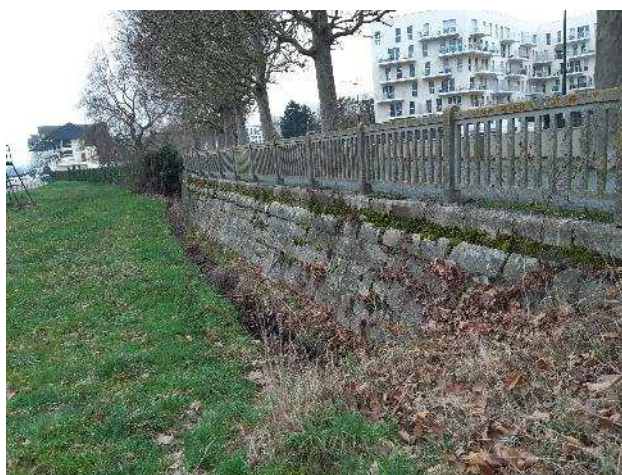
Figure 7-50 : mur de soutènement du talus le long du tronçon BRI_02, la murette est visible en arrière-plan.
