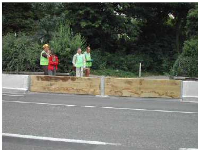
Figure 7-12 : illustration des fissurations observées.
