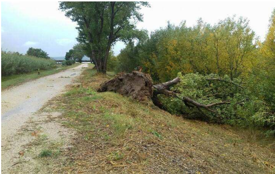
Figure 6-7 : Illustration d'un chablis sur la digue de l'Agly Maritime (ISL, 2019)
