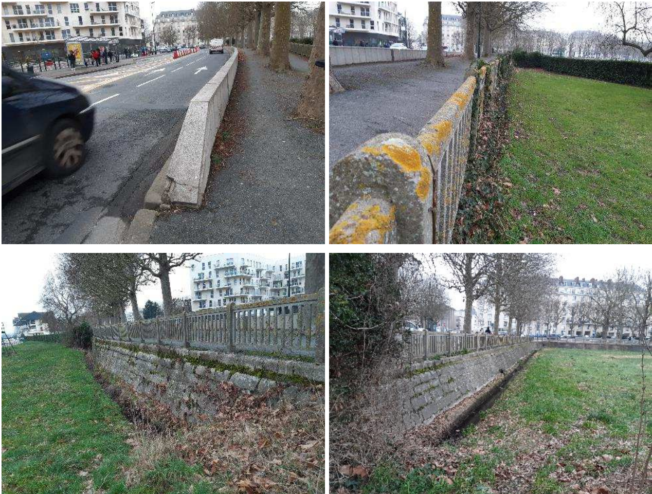
Figure 7-31 : vue d'ensemble de la murette et mur de soutènement du talus côté hippodrome.
