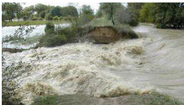
Figure 6-4 : Rupture de digue par surverse du Vidourle à Marsillargues lors de la crue de septembre 2002 (source : mairie de Marsillargues).
