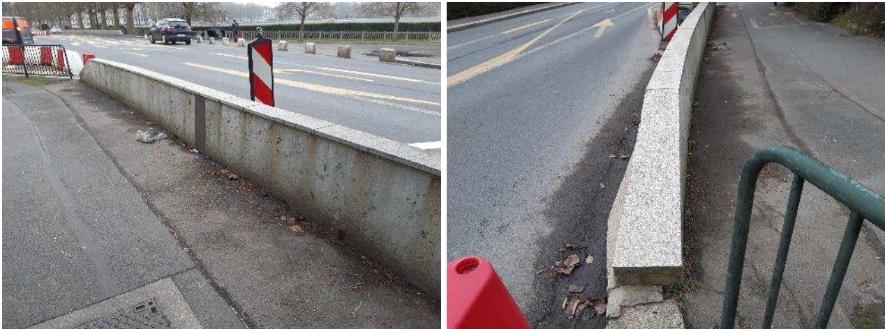
Figure 7-24 : vues d'ensemble de la murette.
