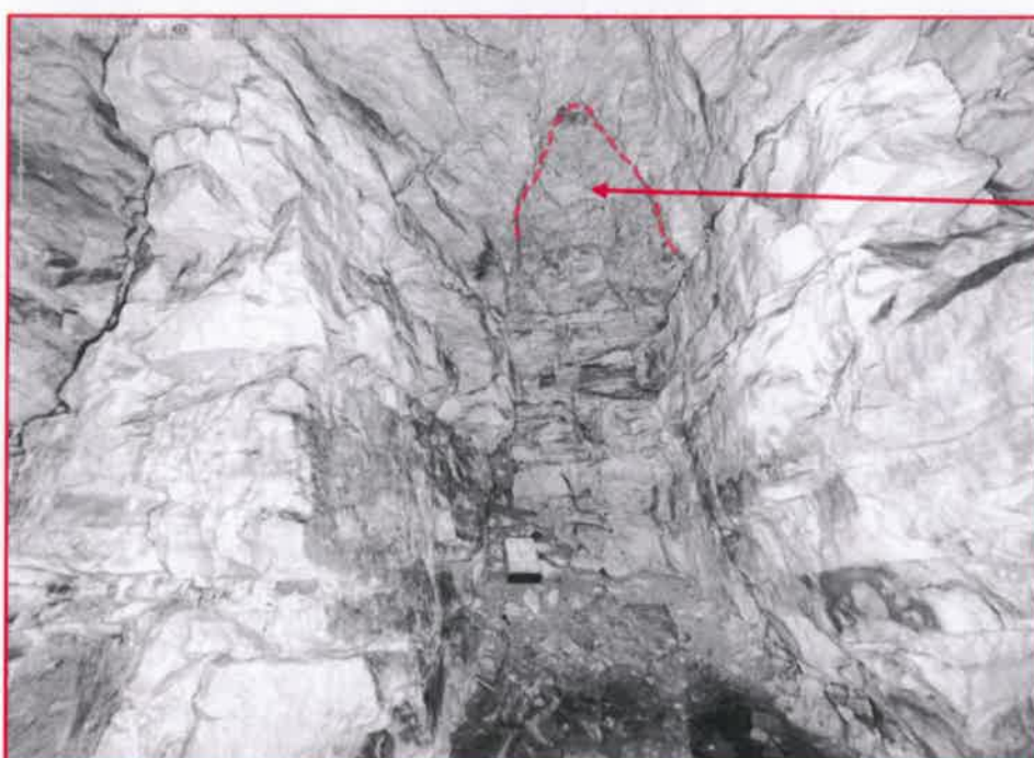
Photo 9 :Chambre n°2, vue sur le fontis au plafond
