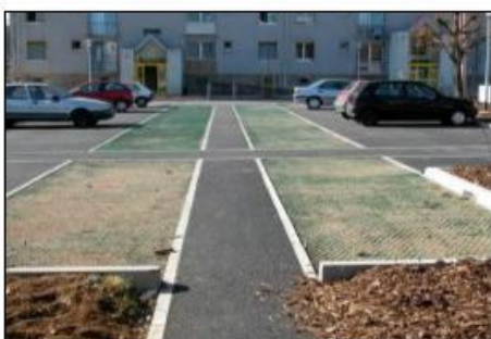
Exemple de parking réservoir à Albi
