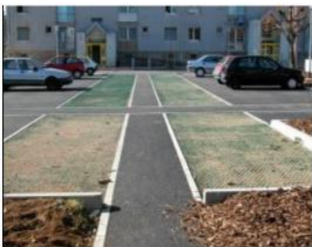
Exemple de parking réservoir à Albi
