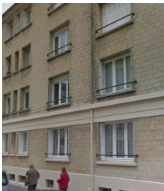
Les logements situés au rez-de-chaussée des immeubles de la Reconstruction sont surélevés par rapport au trottoir de manière à préserver l'intimité des logements : les fenêtres se trouvent au-dessus du regard des passants.
