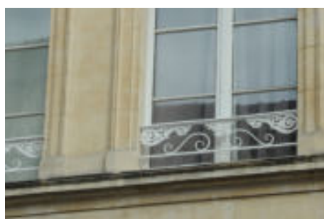
Les garde-corps anciens peuvent être mis aux normes par ajout d'éléments conçus en accord avec le dessin du garde-corps d'origine.
