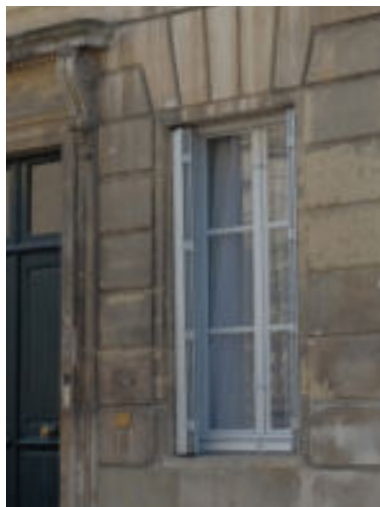
Volets pliants d'origine Ils peuvent être en bois ou en acier.
