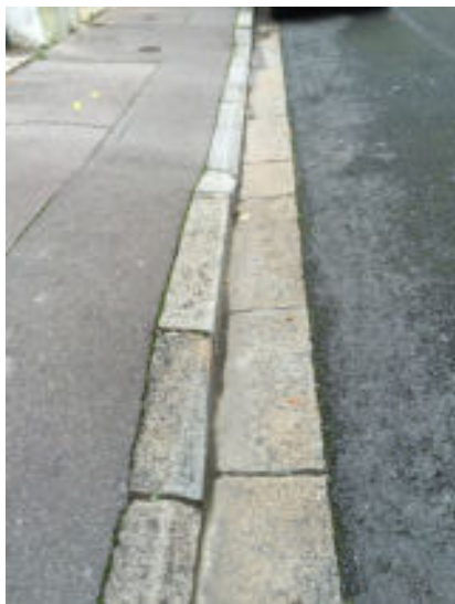
Bordure de trottoir et caniveau en granit.
