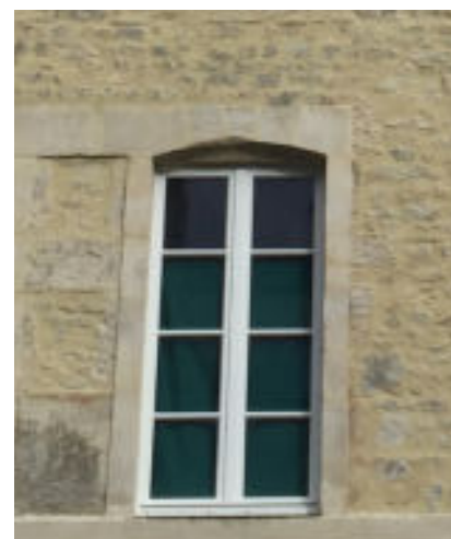
Maçonnerie de pierre de taille et moellons à joints beurrés*, très courante. (* largement remplis)
