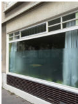
Grande vitrine horizontale incluant une partie haute divisée pour intégrer la ventilation, allège en carreaux de terre cuite vernissée noire, bandeau sous la corniche pour placer l'enseigne.
