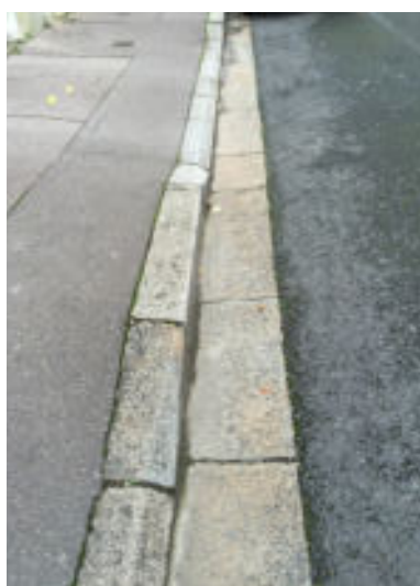
Bordure de trottoir et caniveau en granit.
