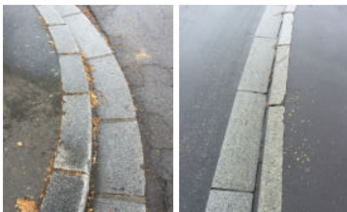
Bordures de trottoir courbes en granit.
