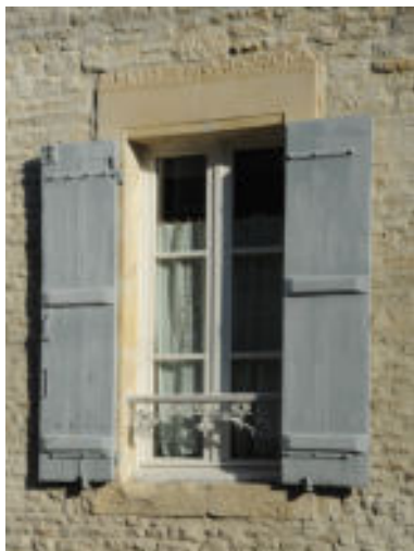
Volets battants à barres droites sur un bâti de faubourg.
