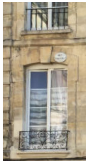
Garde-corps supérieur non cohérent avec le garde-corps inférieur d'origine.
