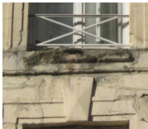
● Modénature en pierre de taille à réparer.
