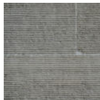
Finition layée, joints pleins très fins.
