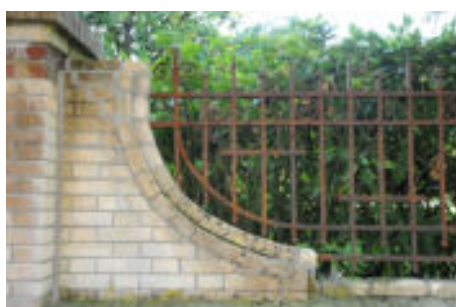
Détail d'une grille de style Art déco, conçue avec le mur en brique ; elle nécessite une protection antirouille et une peinture.
