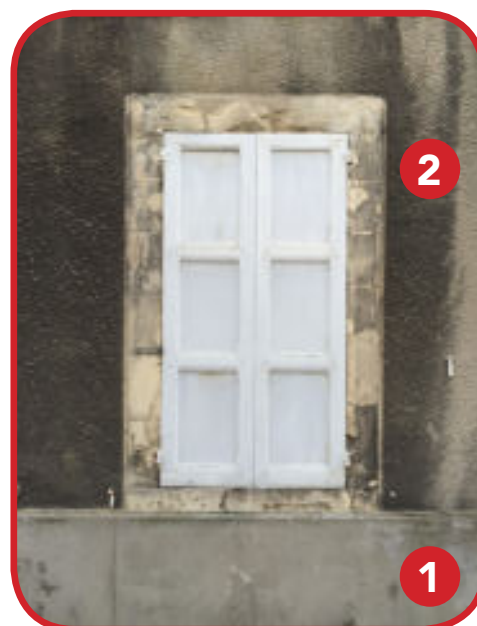
● Modénature en pierre de taille à réparer.
