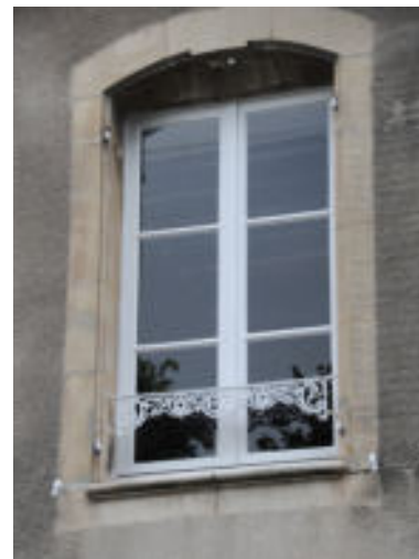
Les volets ont été déposés : présence de gonds et d'arrêts de volets.
