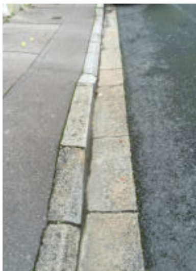
Bordure de trottoir et caniveau en granit.
