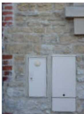
Coffrets de branchement Encastrement correct.
