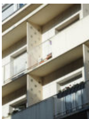
Séparatif de balcon en béton avec incorporation de pavés de verre.
