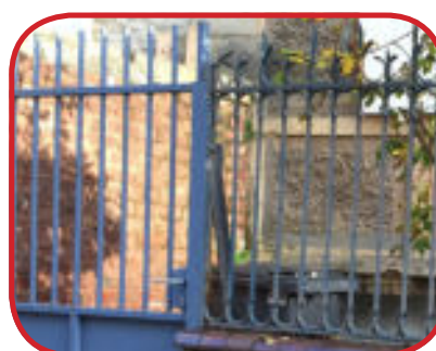
Détail d'une grille de style Art déco, conçue avec le mur en brique ; elle nécessite une protection antirouille et une peinture.
