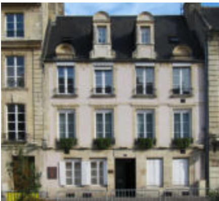
Hôtel particulier XVIIIe siècle lié à l'aménagement urbain de la place Saint-Sauveur. Le logis principal de l'hôtel est placé sur le devant. Les propriétaires bourgeois s'affichent sur le domaine public associé au commerce, 17 place Saint-Sauveur.
