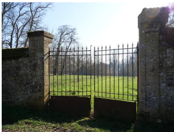
Depuis le portail Est, chemin de la Vallée
