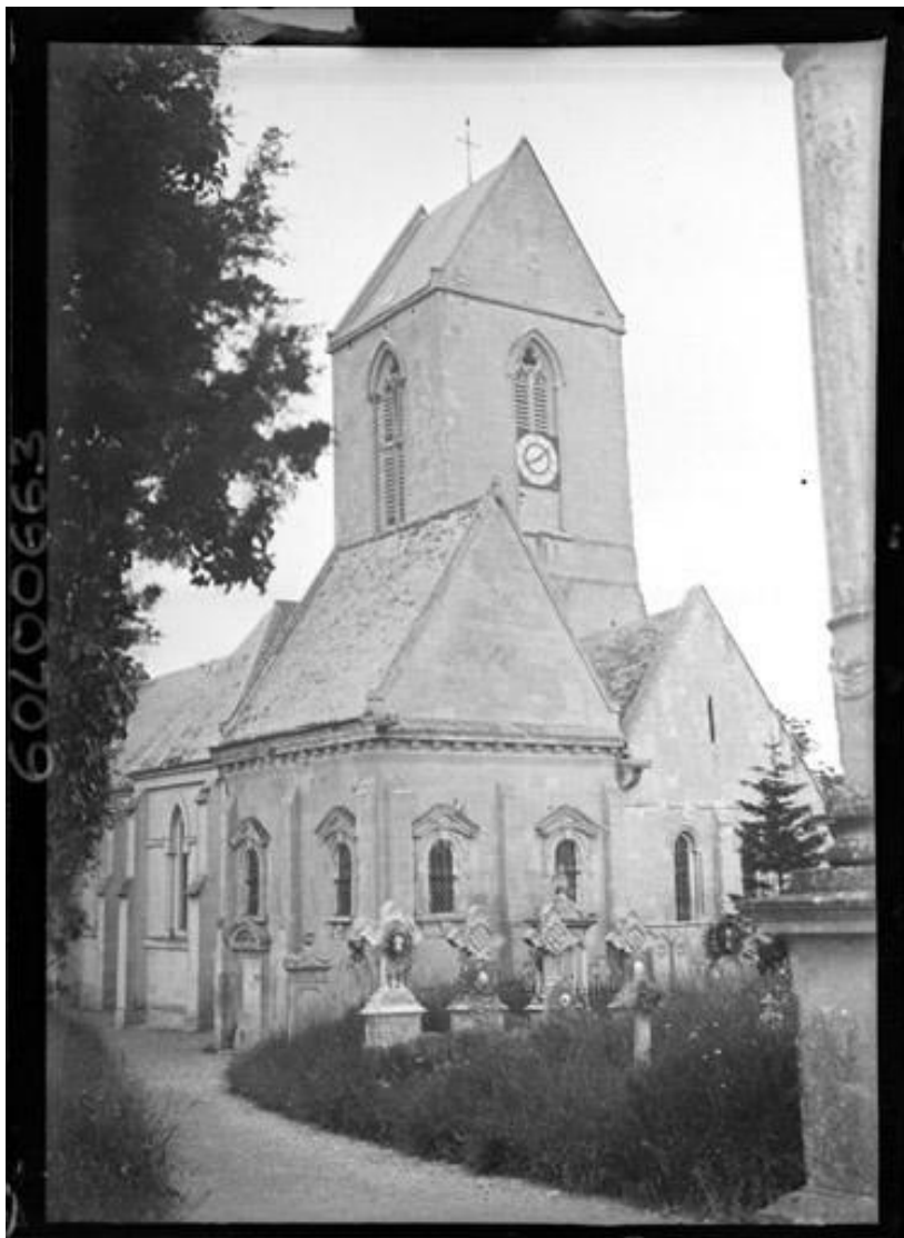
Eglise paroissiale Saint-Manvieu : ensemble sud-est Support verre - Gabriel Ruprich-Robert (1859-1953)
