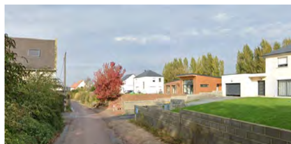
entrée ouest du bourg, rue de la Dîme (RD 126)
