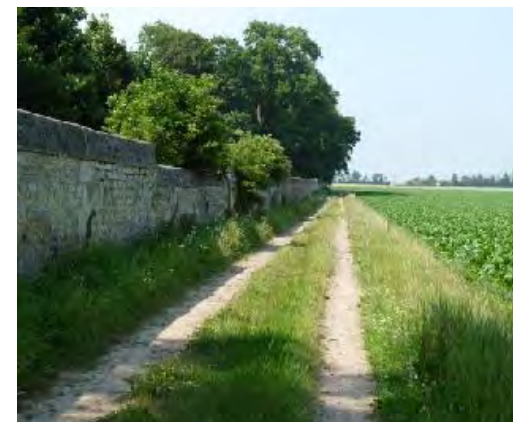
Beau muret sur une partie du chemin filant au nord-ouest vers Cairon.
