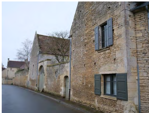
Ancien corps de ferme rue Crois Mare
