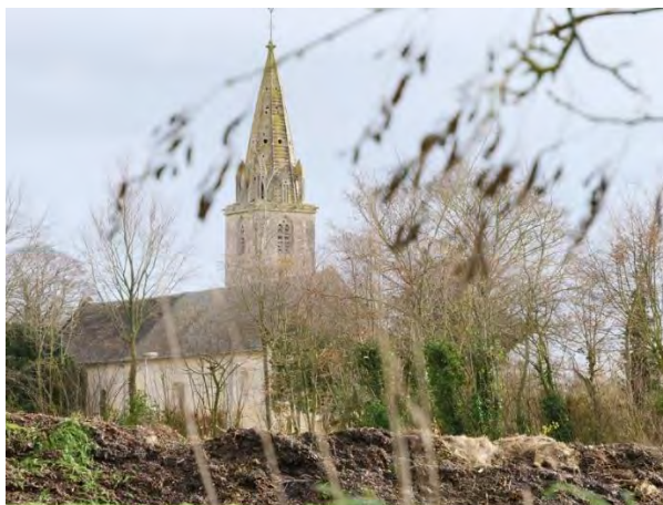
Depuis le chemin nord-ouest rejoignant l'église de Cairon.
