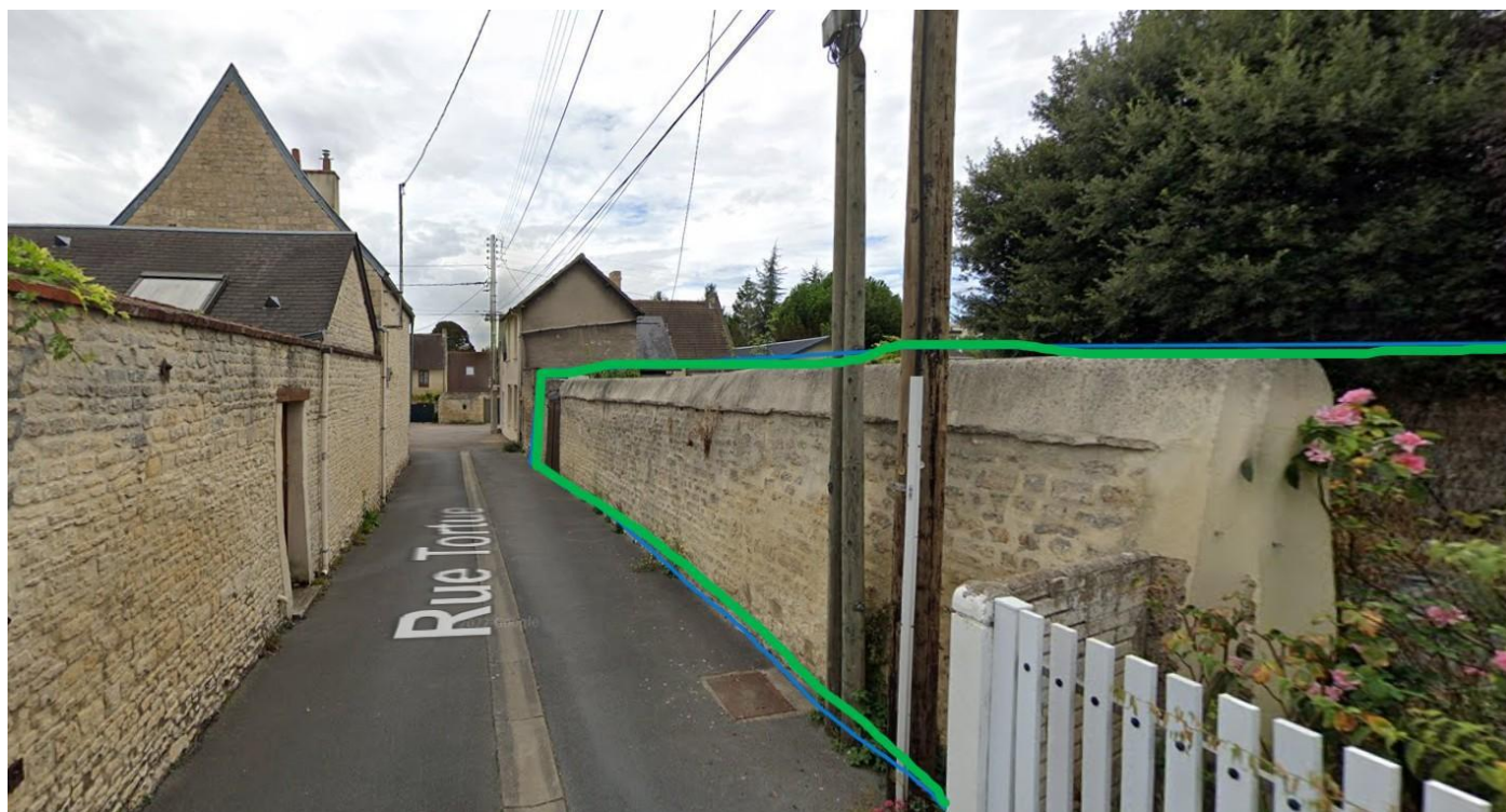
Terrain de la parcelle LX 633 avec son grand mur de pierres de Caen. Vu depuis la rue Tortue, au niveau du voisin du 3.
