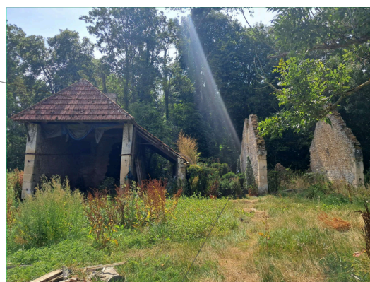
Ancien bâtiment à remettre en état
