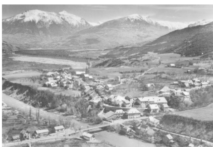
Figure 32 : Vieux village de Savines, installé de l'autre côté du pont sur la nouvelle route tracée au XVIème siècle.
