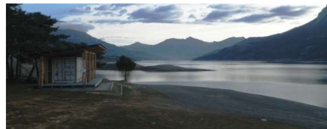
Figure 152 : Serre Ponçon, Aménagement des plages de Serre Ponçon, bâtiment de plage © CAUE 05
