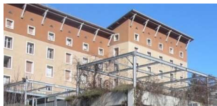
Figure 142 : Rénovation intéressante de patrimoine bâti, Embrun
