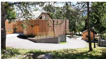
Figure 146 : Puy Sanières, Extension mairie © CAUE 05
