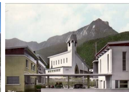
Figure 130 : Savines-le-Lac, Années 60, l'église, la poste, la mairie.
