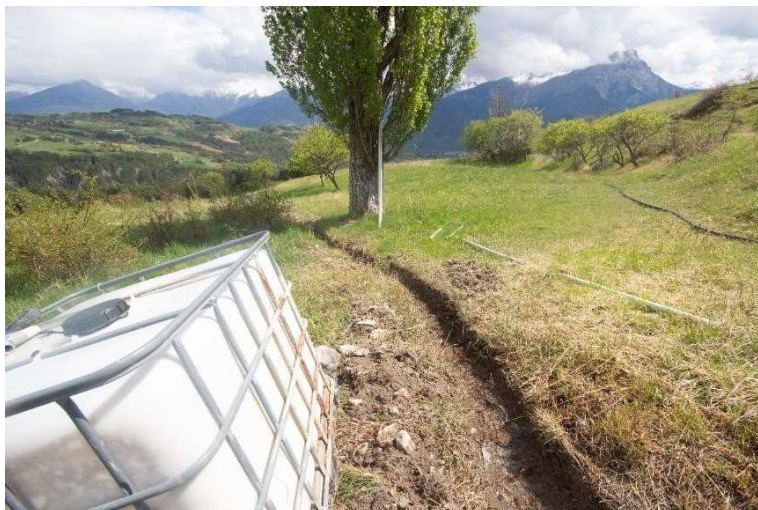
FIGURE 32: CAPTAGE EN COURS DE CREATION AVEC CANALISATIONS ENTERREES, EN AMONT DE LA ZONE HUMIDE DE CHERINES (SAVINES-LE-LAC)
