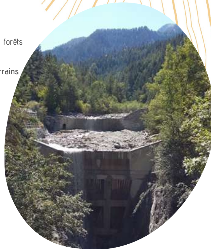
Ouvrage RTM, Crots - Photo : L. Bobet
