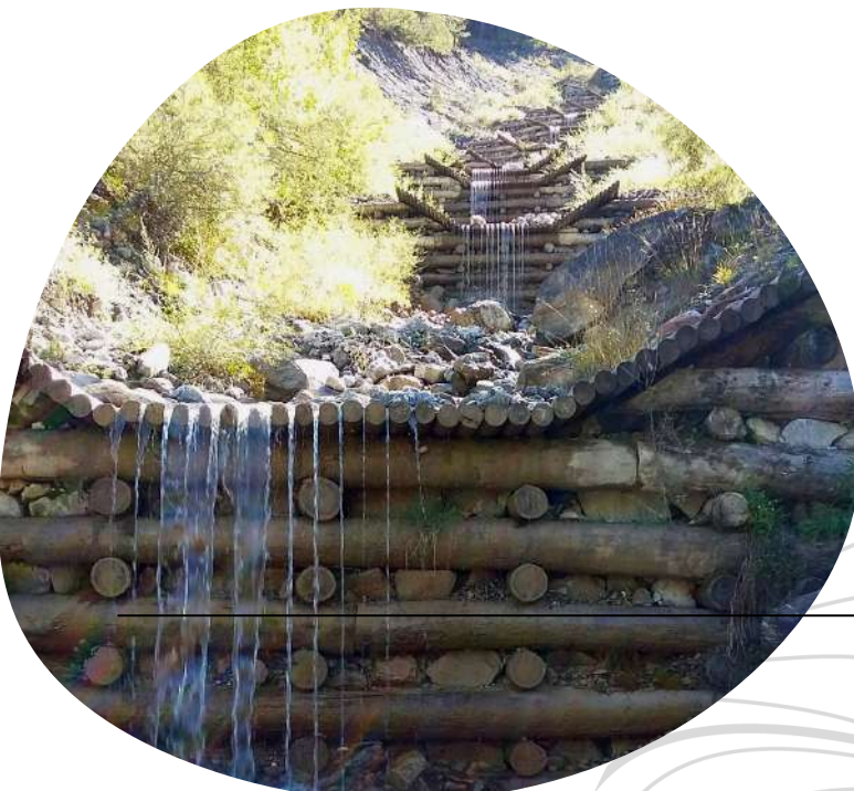
Ouvrage bois sur le torrent de l'Éyssalette, septembre 2021 - Photo : L. Bobet
