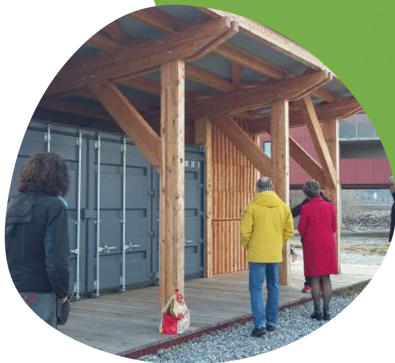
Formation sur l'utilisation des pins dans la construction par les Communes Forestières PACA, février 2021 - Photo : L. Bobet
