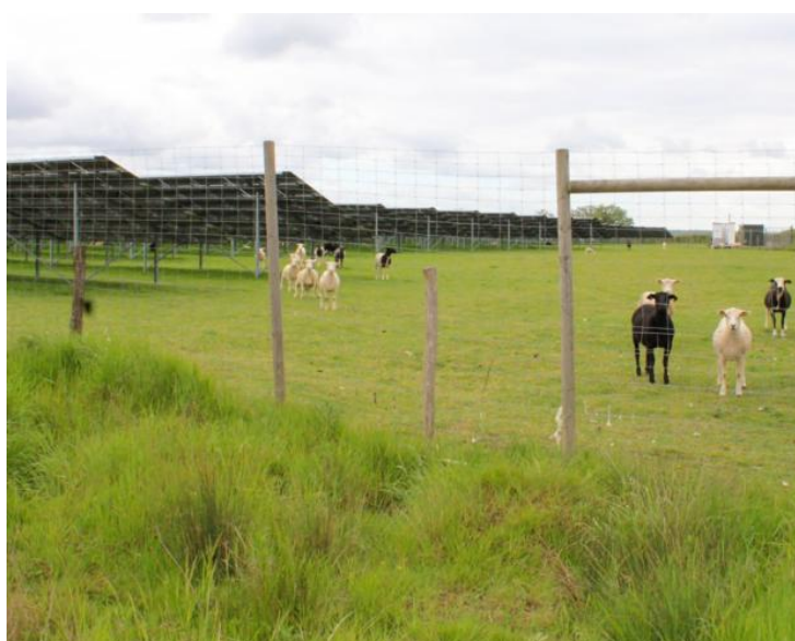
Figure 10 : Clôture à grosse maille installée dans une centrale agri-voltaïque - Source Corieaulys
