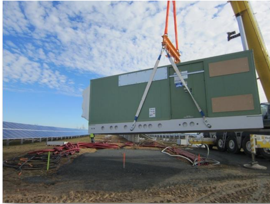
Illustration 57 : Exemple d'installation de poste de conversion
