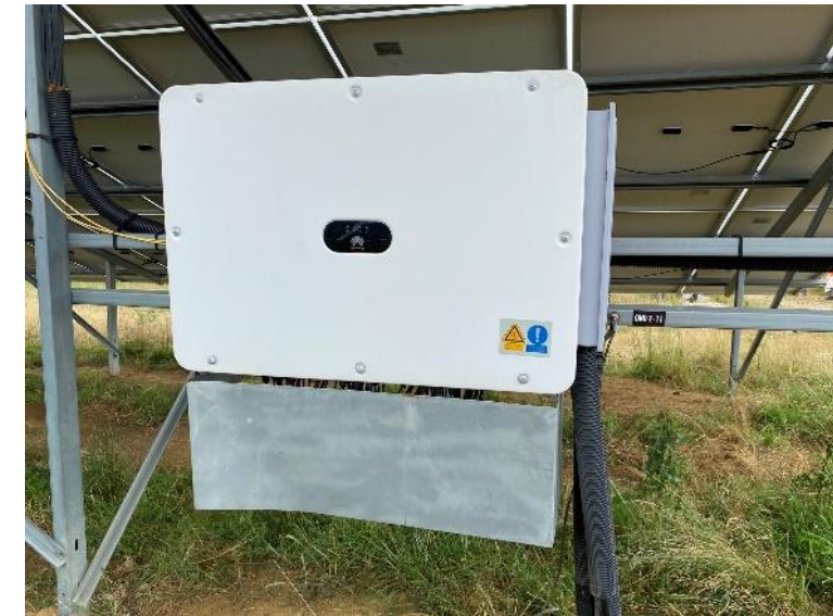
Illustration 48 : Exemple d'onduleur décentralisé
