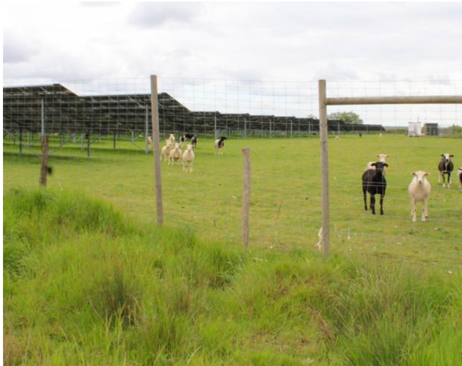
Illustration g1 : Clôture à grosse maille installée dans une centrale agri-voltaïque - Source Corieaulys
