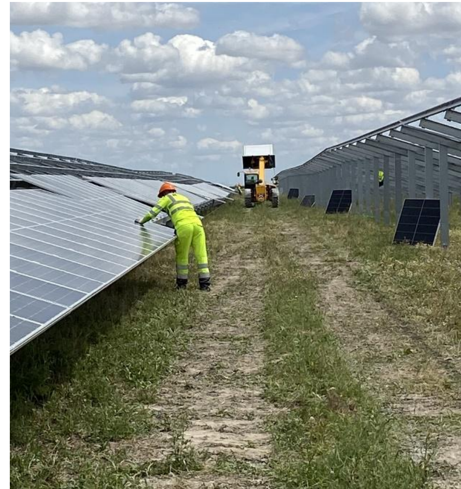
Illustration 56 : Pose de modules
