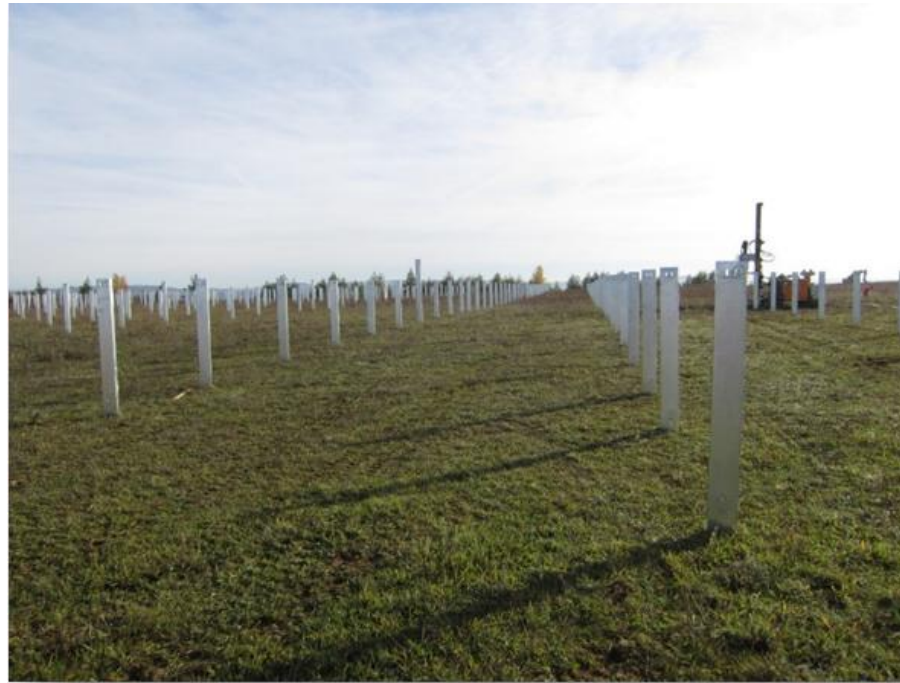
Illustration 55 : Exemple de pieux battus dans le sol avec une batteuse visible en arrière-plan
