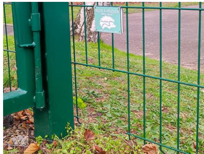
Illustration 50 : Aménagement de transparence écologique des clôtures - Source : Groupe mammalogique normand
