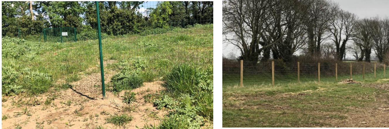
Illustration 49 : Exemple de clôture grillagée (à gauche) et de clôture « URSUS Grande Maille » (à droite)
