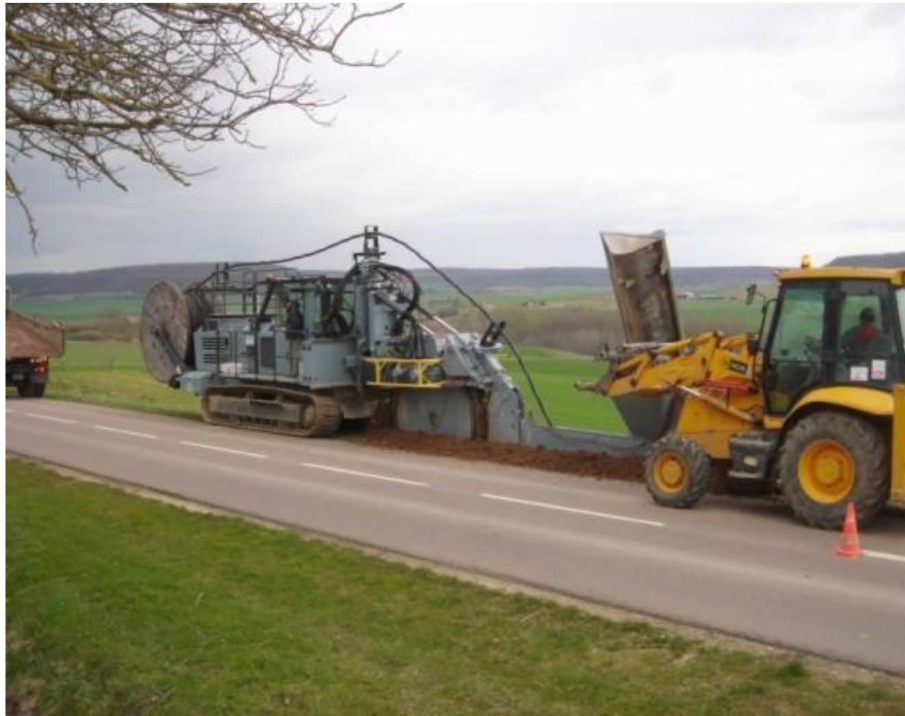
Illustration 52 : Réalisation d'une tranchée
