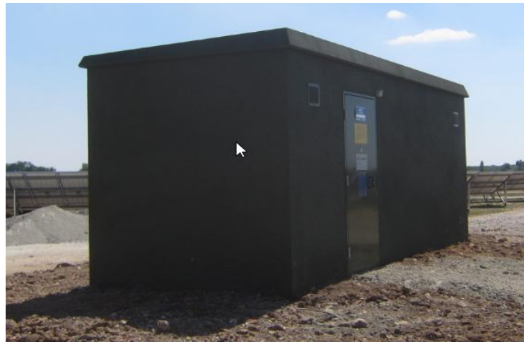
Illustration 46 : Exemple de poste de conversion « indoor »
