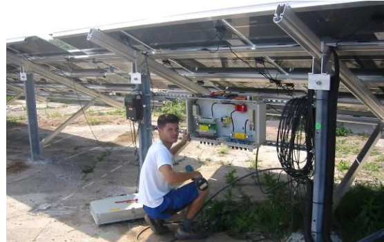
Raccordement de câbles solaires en coffret électrique
