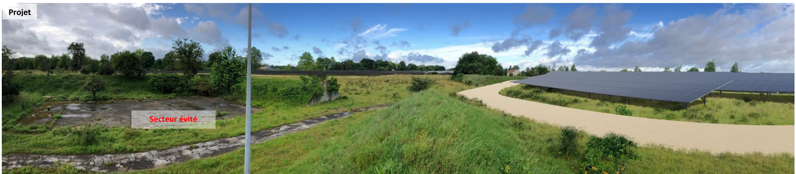
Vue depuis une butte au nord-est du projet en direction de l'ouest (vue n°3)
