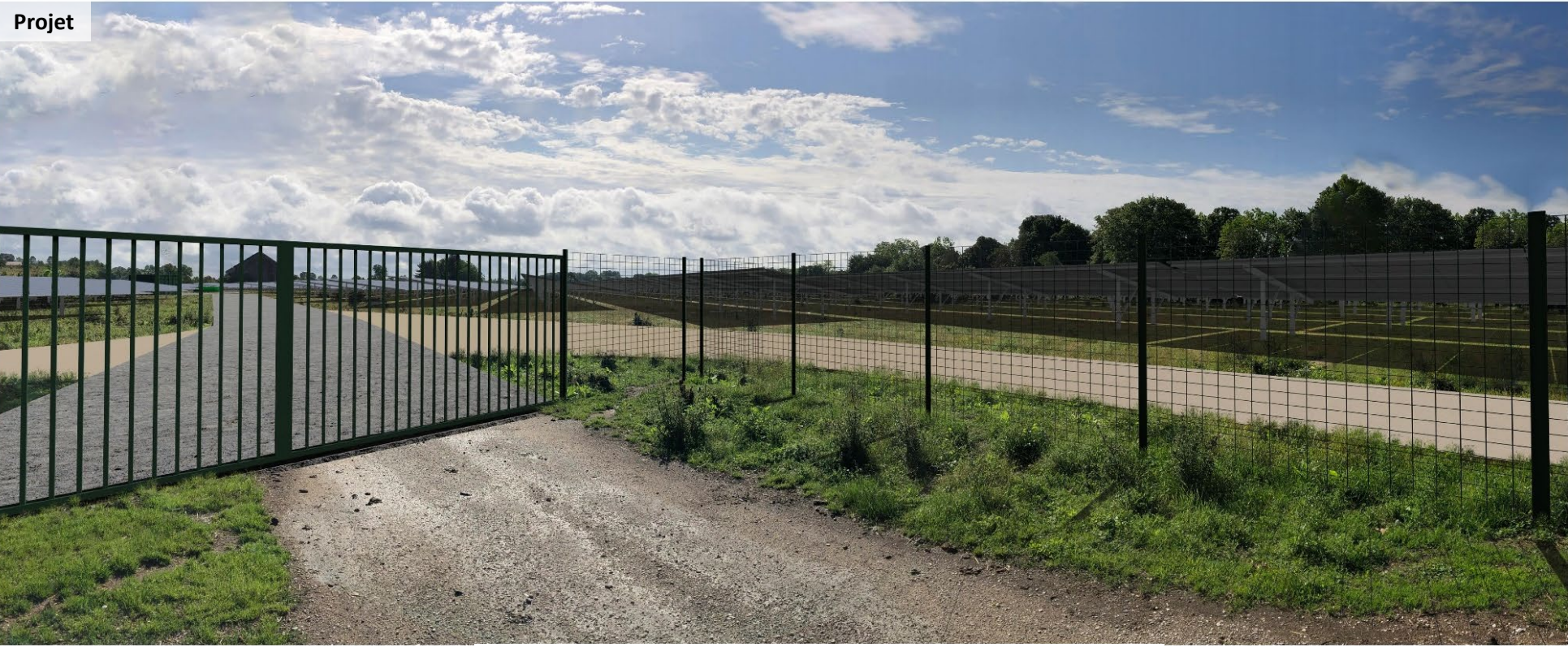
Vue depuis la piste existante permettant l'accès à l'emprise clôturée nord (vue n°5)
