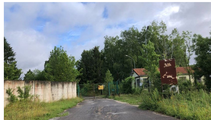
Accès au site : voiries et accès déjà existants . (credit photo SCE)
