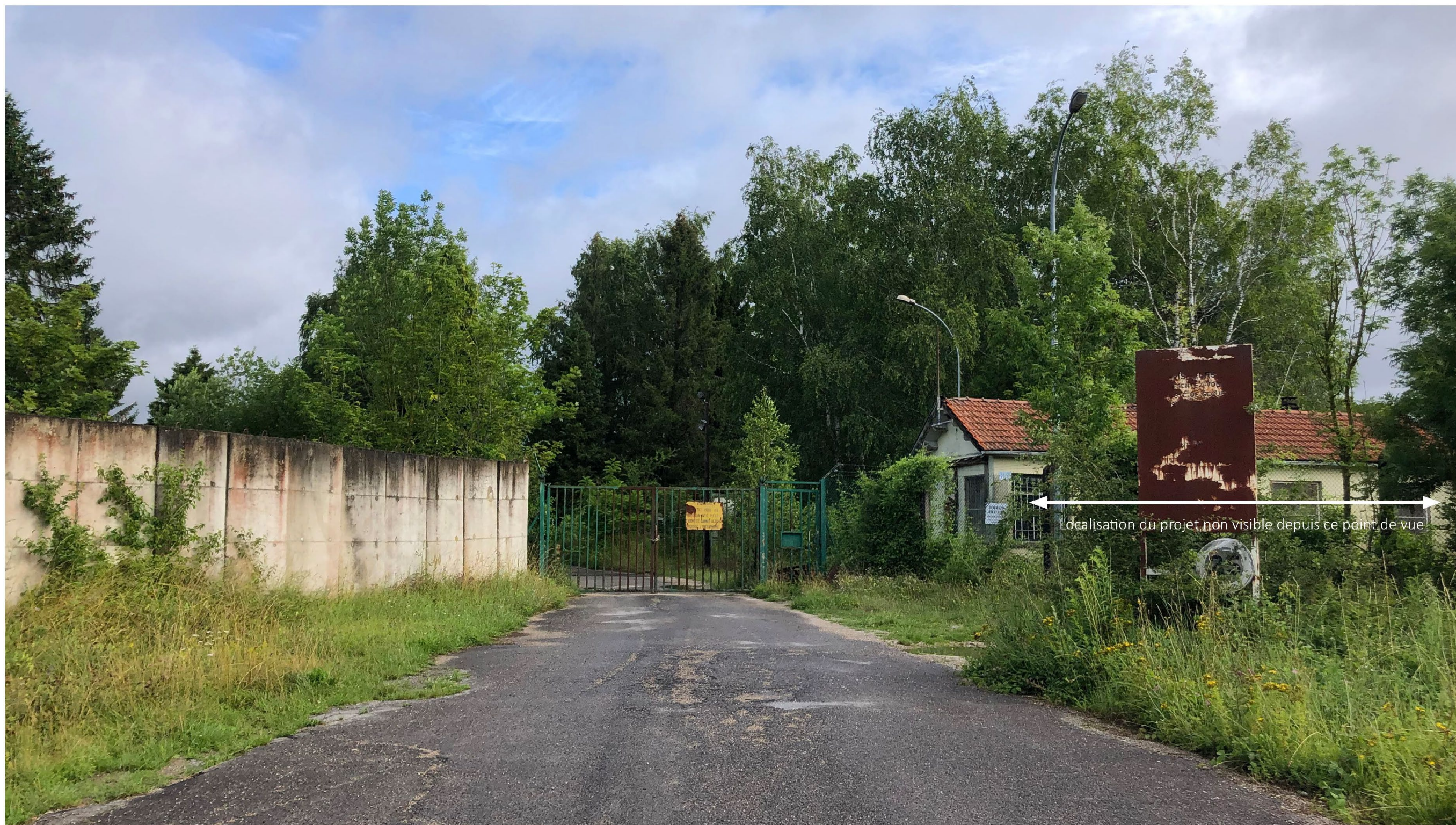
Figure 139 : Vue n°1 – Vue depuis la piste existante reliant le site militaire à la Route départementale n°35
