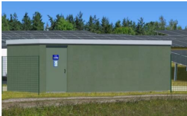
Figure 11 : Exemple d'un poste de livraison (Source : EDF Renouvelables)
