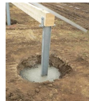
Photographie 4 : Fondation béton (à gauche) ; fondation vis (à droite)
