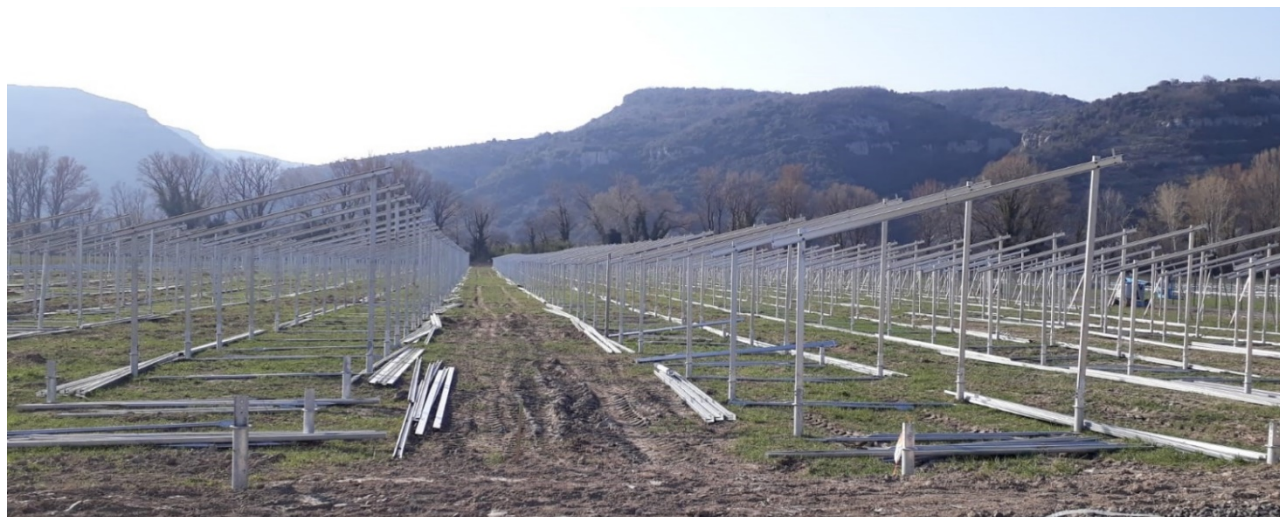
Photographie 6 : Exemple de structures et fondations par pieux en acier
