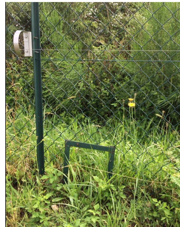
Figure 17 : Photographie de la clôture et du passage à faune (source : EDF-R)
