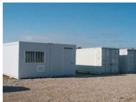
Photographie 2 : Installation de la base-vie
