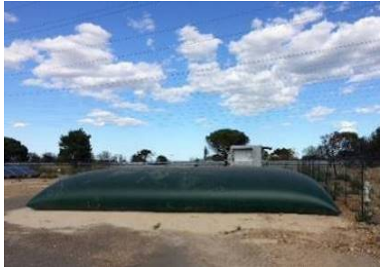
Figure 18 : Exemple d'une citerne souple (Source : EDF Renouvelables)
