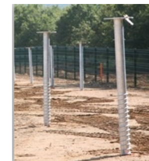
Photographie 4 : Fondation béton (à gauche) ; fondation vis (à droite)
