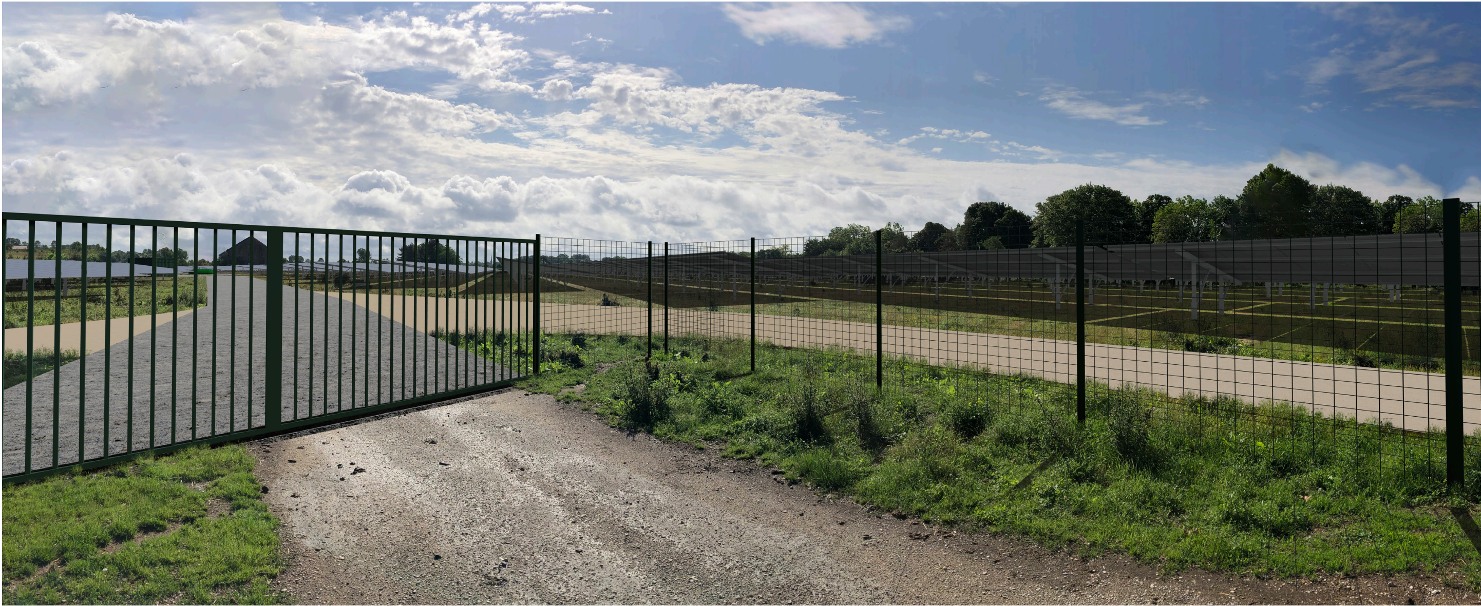
Point de vue n°5- Vue depuis la piste existante permettant l'accès a l'emprise clôturée nord
