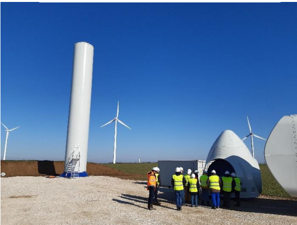
Visite de chantier de la Ferme éolienne du Boie Elie (février 2023)
