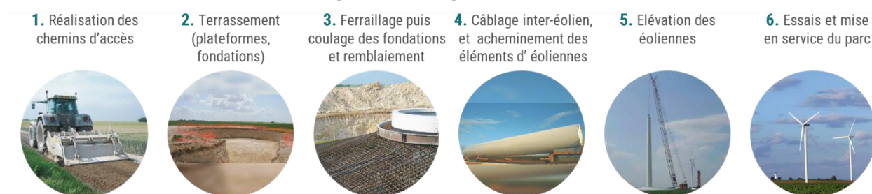
Figure 1 : Phasage des travaux
