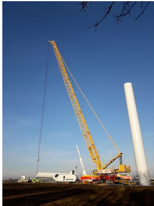
Figure 66 : Grue permettant l'assemblage des différents éléments d'une éolienne (Source : VOLKSWIND)
