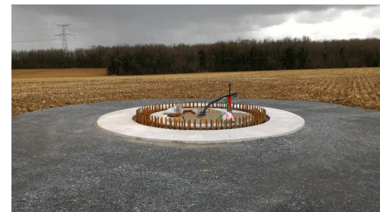
Figure 69 : Fondation finalisée (Source : VOLKSWIND)
