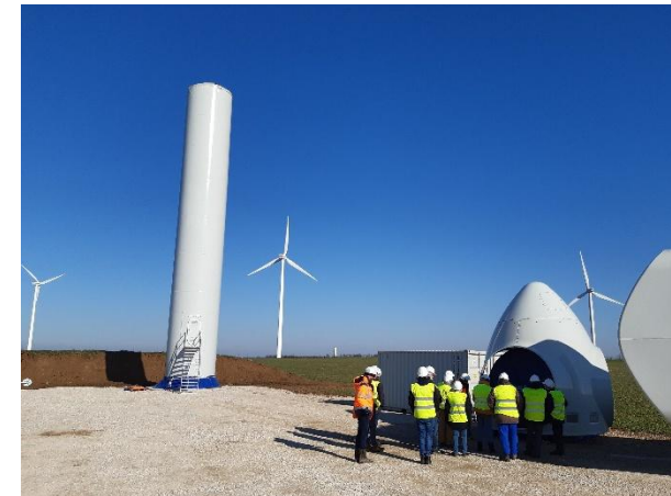
Figure 41 : Visite de chantier de la Ferme éolienne du Bois Elie (février 2023)
