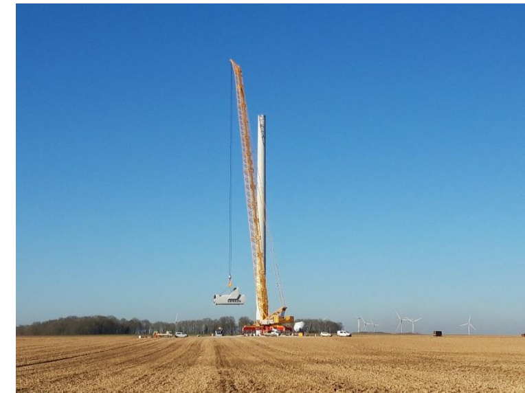
Figure 72 : Montage de la nacelle (Source : VOLKSWIND)
