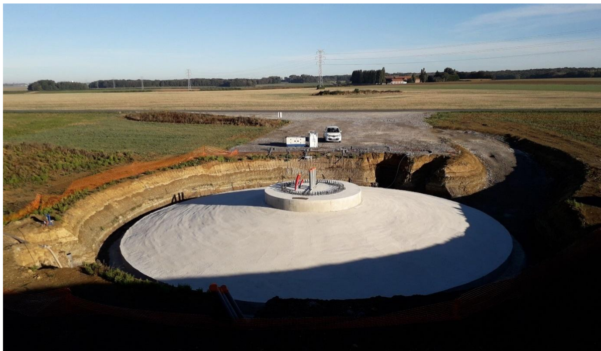
Figure 65 : Fondation après coulage béton (Source : VOLKSWIND)
