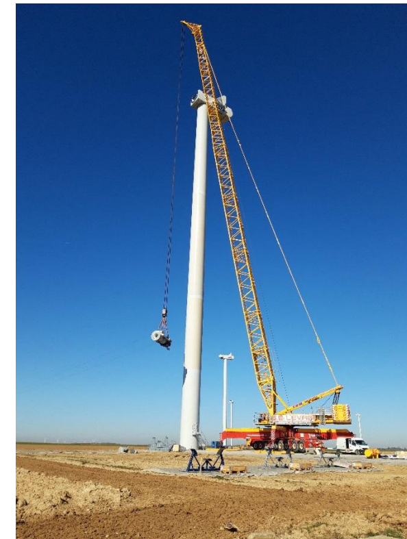
Figure 73 : Montage de la génératrice (Source : VOLKSWIND)
