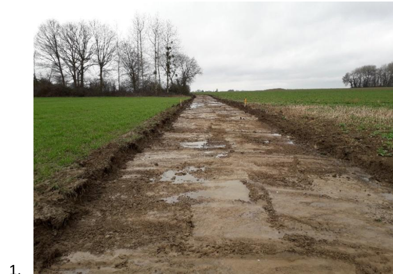
Figure 63 : Création de chemin 1 - Décapage, 2 - Traitement à la chaux, 3 - Etat final (Source : VOLKSWIND)
