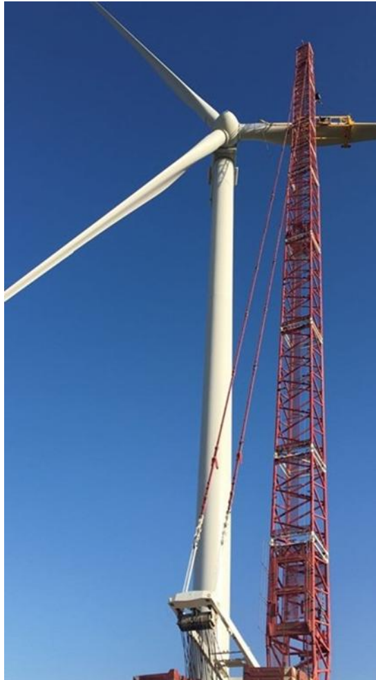
Figure 74 : Montage des pales (Source : VOLKSWIND)
