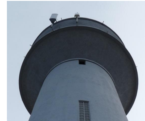
Figure 92 : Installation d'un réémetteur sur un château d'eau
