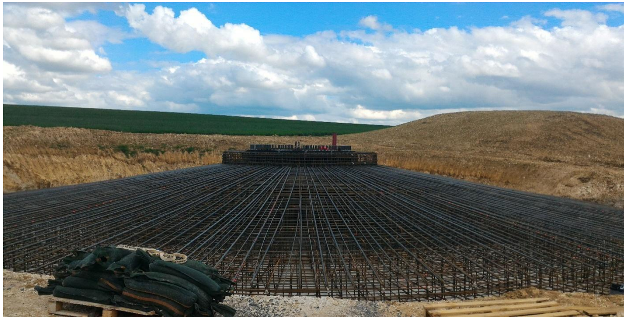
Figure 64 : Ferrailage du massif (Source : VOLKSWIND)
