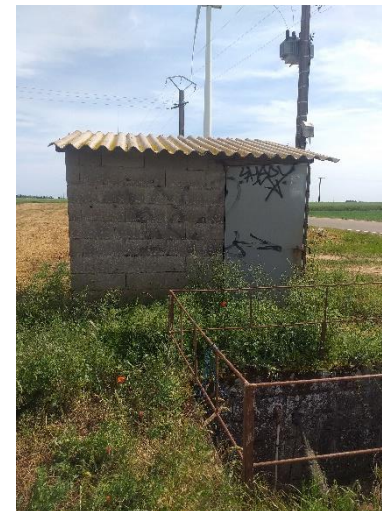
Photo 18. Station de pompage pour irrigation
