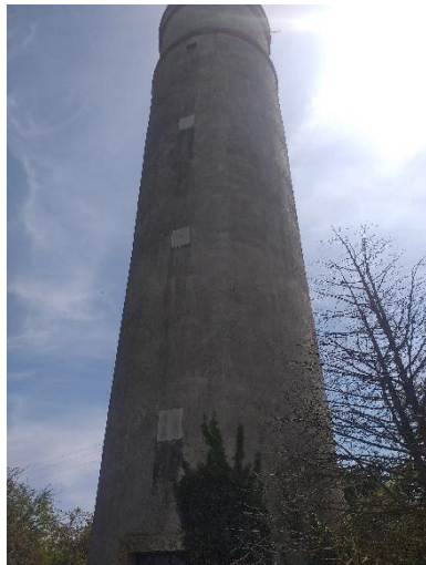
Photo 20. Ancien château d'eau
